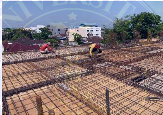
Gambar 4.4 Perakitan Besi Tulangan Sumber: Dokumen Lapangan 2024
