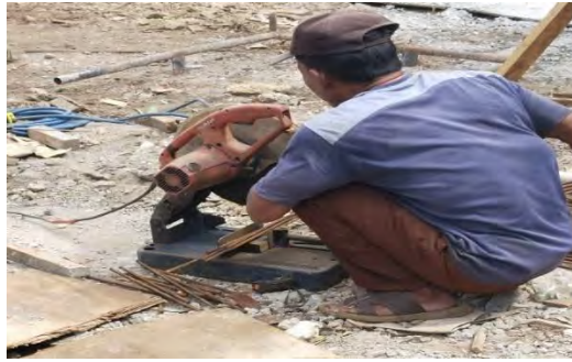
Gambar 4.3 Pemotongan Besi Tulangan Sumber: Dokumen Lapangan 2024
