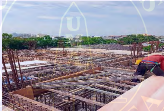
Gambar 4.2 Memasang Kayu dan Multipleks (Bekisting)
