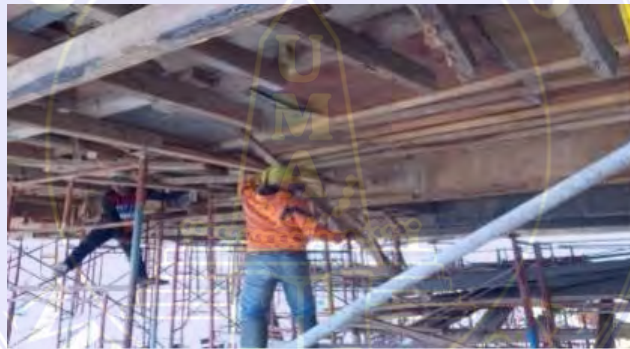
Gambar 4.7 Pelepasan Bekisting Sumber: Dokumen Lapangan 2024
