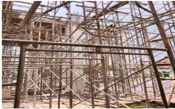
Gambar 4.1 Pemasangan Scaffolding
