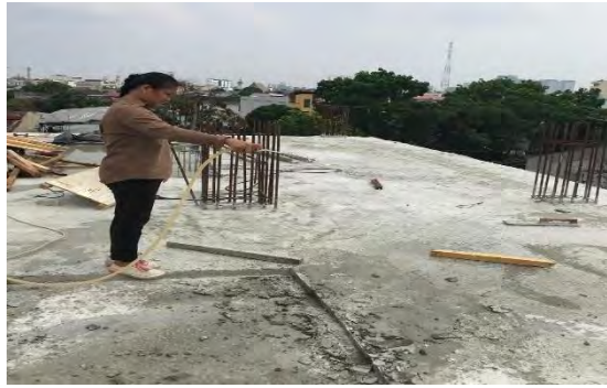
Gambar 4.8 Curing Beton Sumber: Dokumen Lapangan 2024
