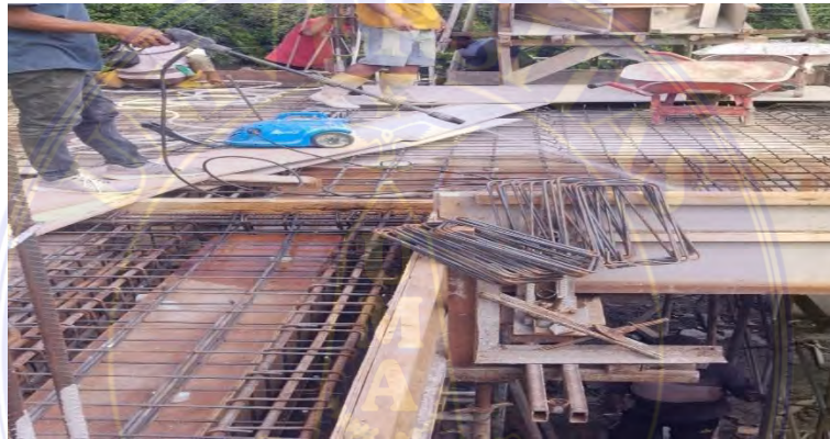
Gambar 4.5 Penyiraman Sebelum Pengecoran Sumber: Dokumen Lapangan 2024
