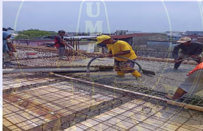
Gambar 4.6 Pengecoran Pelat Lantai Sumber: Dokumen Lapangan 2024
