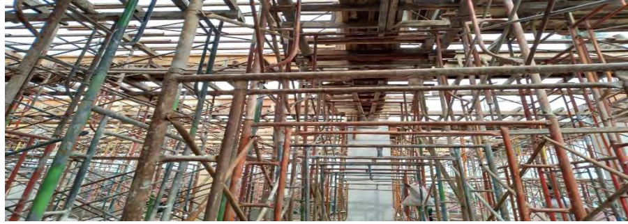
Gambar 4.3.3 Pemasangan bekisting
