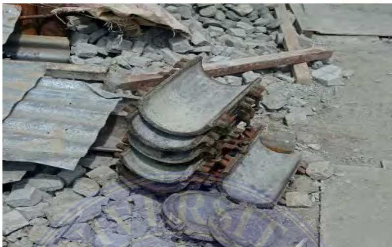
Gambar 3.1.24 : Bekisting Silinder Sampung
