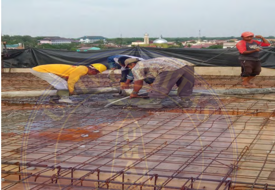
Gambar 4.3.4 Pengecoran Balok
