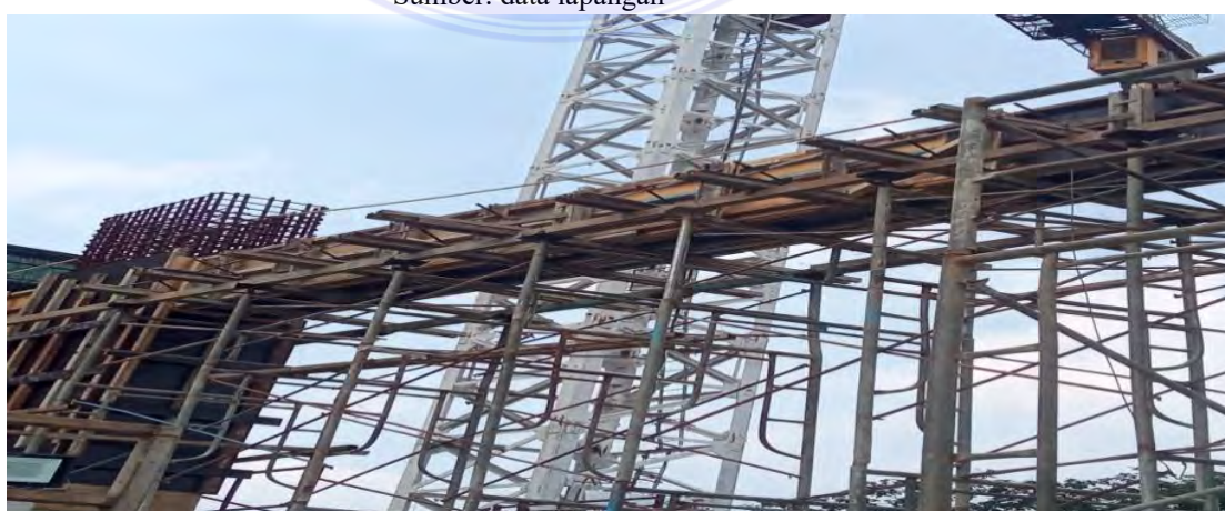
Pemasangan Bekisting pada Balok Sumber : data lapangan
