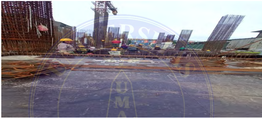
Gambar 4.2 pemasangan bekisting balok
