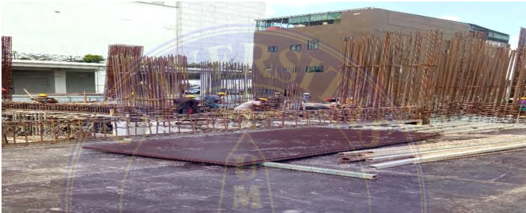
Gambar 4.5 pembongkaran bekisting
