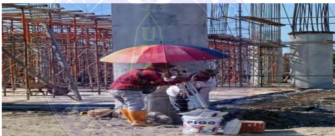
Penentuan Marking Balok Sumber: data lapangan
