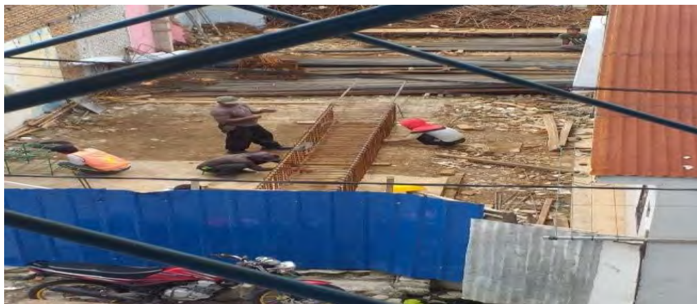
Proses Penulangan Balok sumber: Data Lapangan
