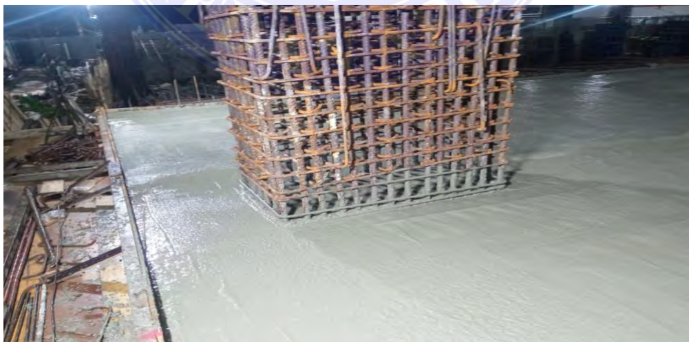
Gambar 4.4 pengecoran balok
