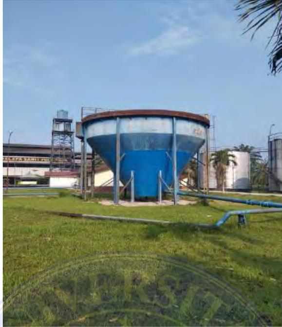
Gambar 3.24. Tangki Pengendapan ( *Clarifier tank* )
