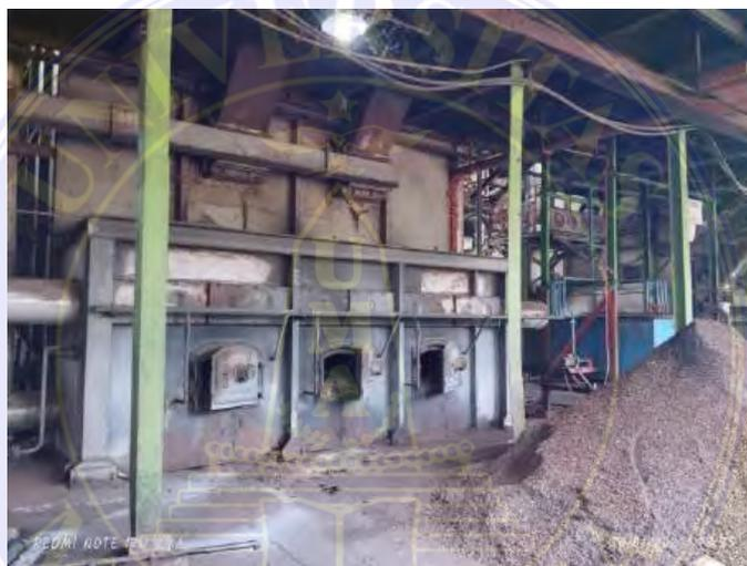
Gambar 3.31. Boiler dan Tungku Boiler
