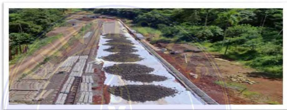
Gambar 4. 3 perkuatan tanah dasar dengan sirtu dan *geotextil*
