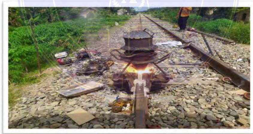
Gambar 4. 10 pengelasan *thermit*
