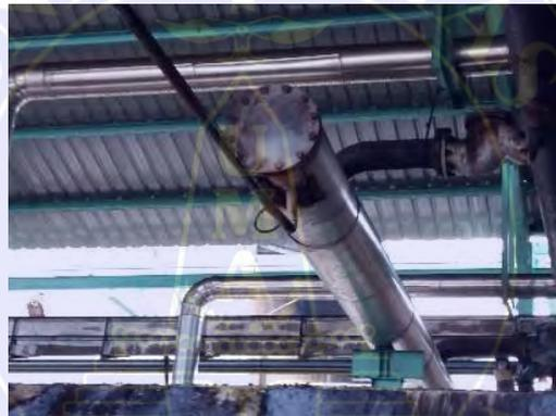
Gambar 3.7. Pipa uap dari BPV (*Back Pressure Vessel*) ke Perebusan (*Pipa Steam*)
