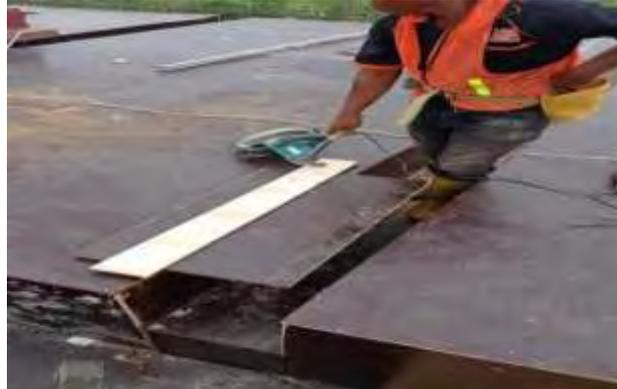
Gambar 4. 4 Pemasangan *Bekisting*
