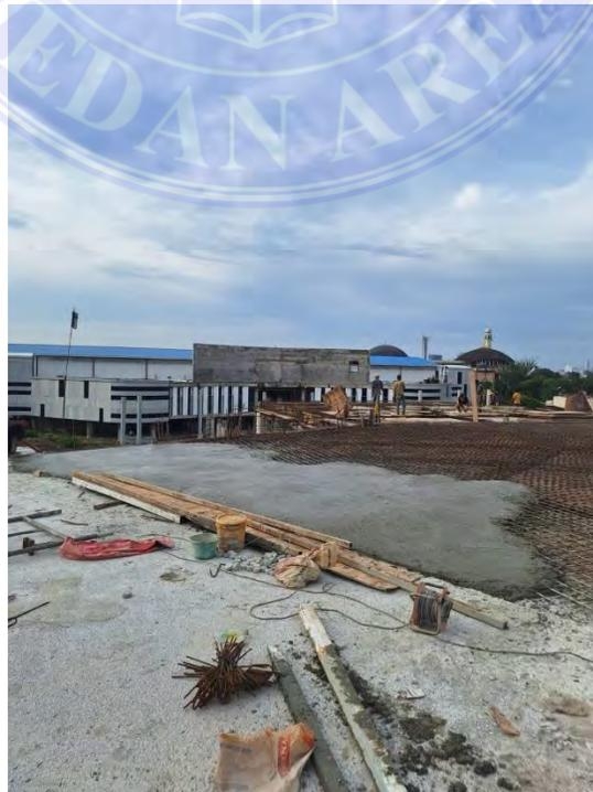
**Gambar 4. Pembesian & pengecoran gedung Segmen B**
