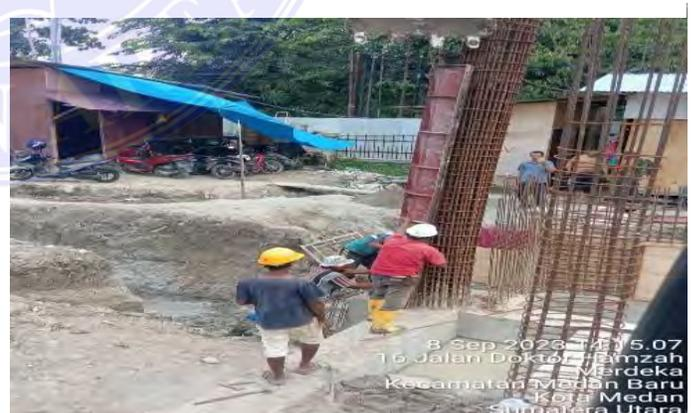
**Gambar 6. Pemasangan column mould**
