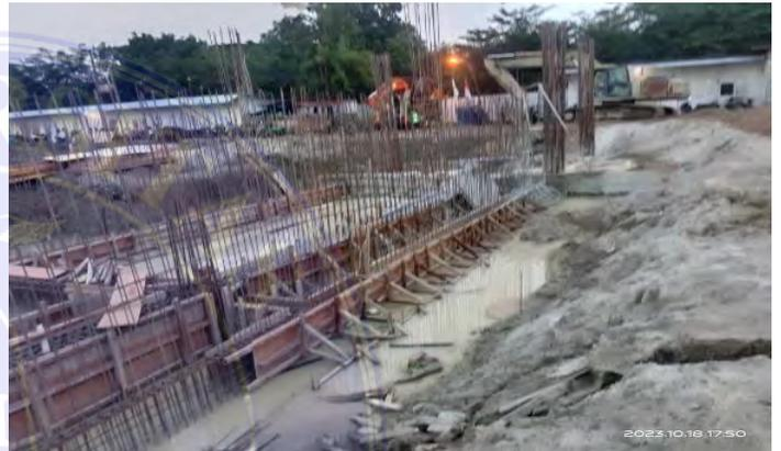
**Gambar 10. Pekerjaan penulangan shear wall**
