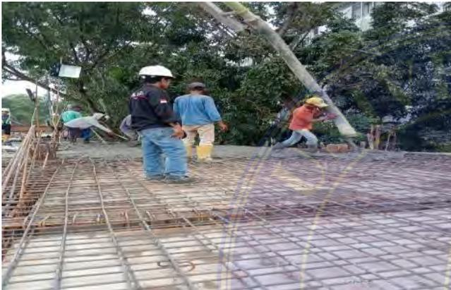
**Gambar 9. Pengecoran plat lantai & balok**
