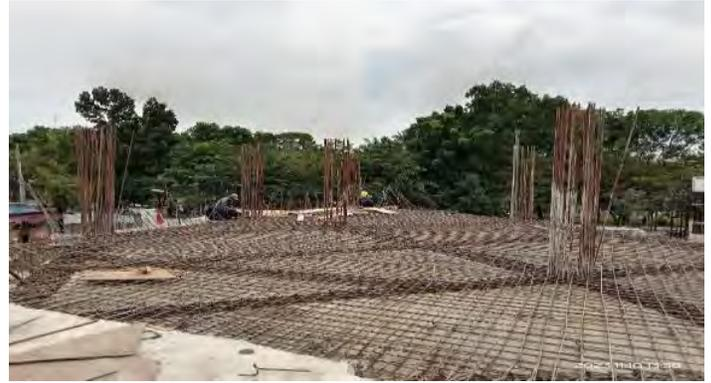
**Gambar 8. Penulangan plat lantai & balok**
