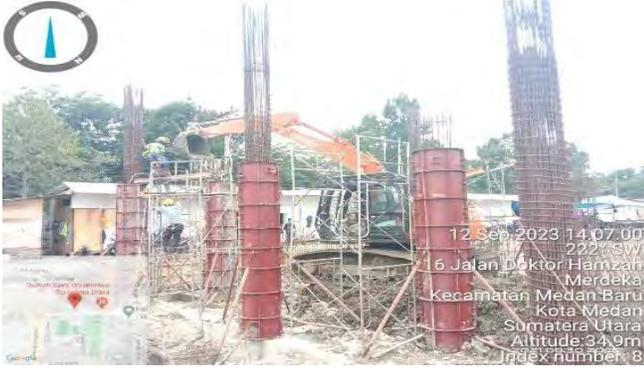
**Gambar 7. Pengecoran kolom**
