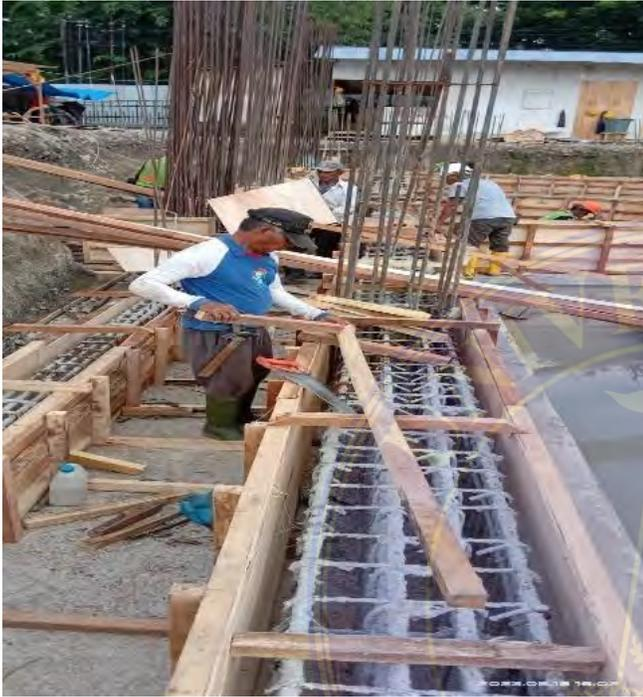
**Gambar 3. Pekerjaan bekisting pondasi**
