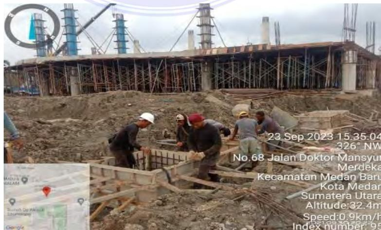
**Gambar 2. Pekerjaan pembesian pondasi**
