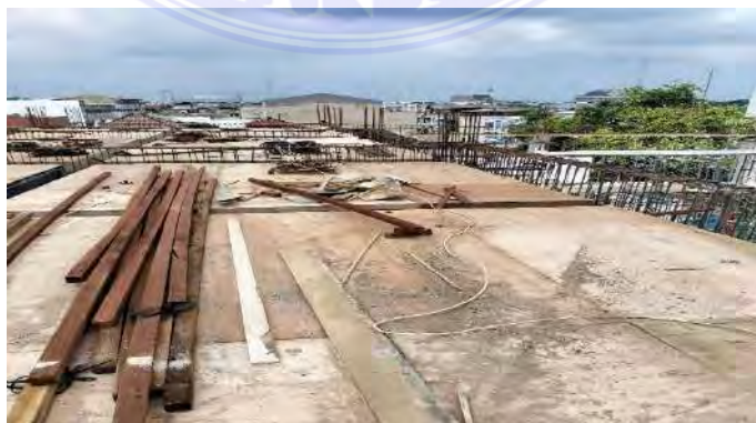
Gambar 4. 3 Pemasangan Papan Bekisting Sumber : Data Lapangan
