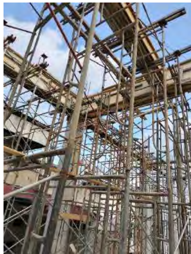
Gambar 4. 2 Pemasangan Scaffolding Sumber : Data Lapangan
