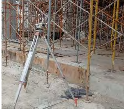
Gambar 3.4 Waterpass Sumber : Data Lapangan
