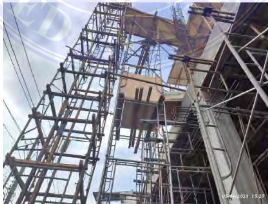
Gambar 3.29 Lift Beton Sumber : Data Lapangan
