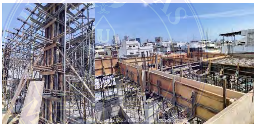
Gambar 3.9 Bekisting Sumber : Data Lapangan
