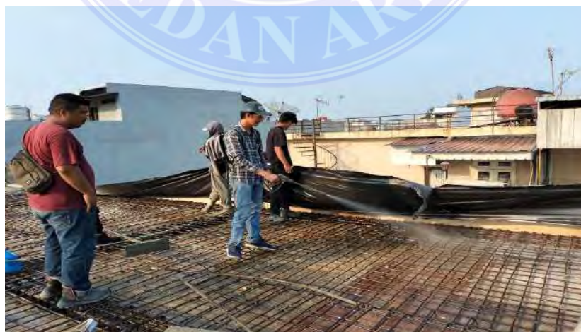
Gambar 4.6 Penulangan Balok
