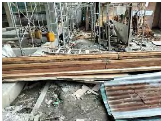
Gambar 3.37 Kayu Sumber : Data Lapangan
