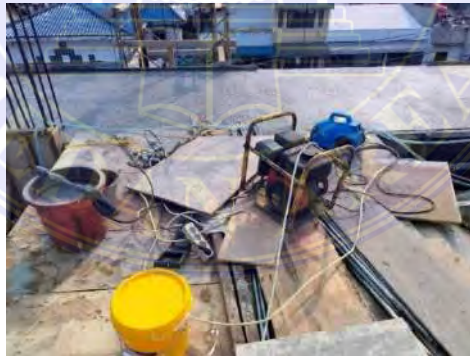
Gambar 3. 3 Beton Vibrator Sumber : Data Lapangan
