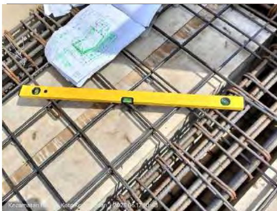
Gambar 3.24 Waterpass Sumber : Data Lapangan
