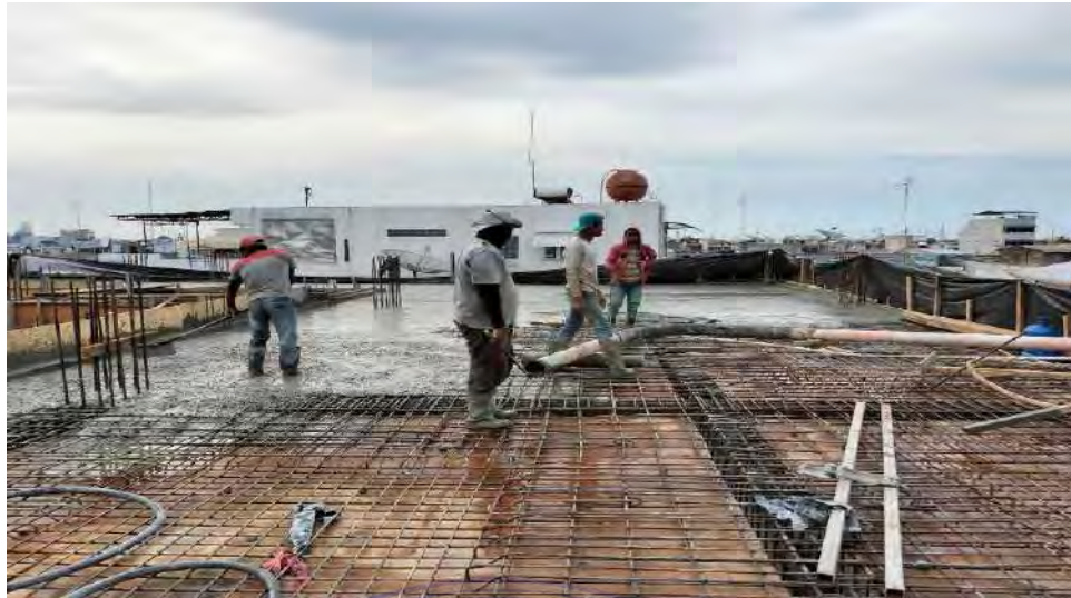
Gambar 4.5 Pengecoran Lantai Sumber : Data Lapangan
