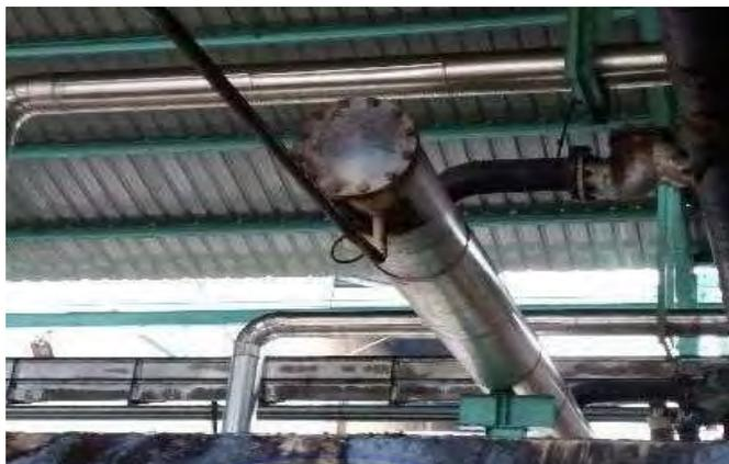
Gambar 3.5. Pipa uap dari BPV (*Back Pressure Vessel*).
