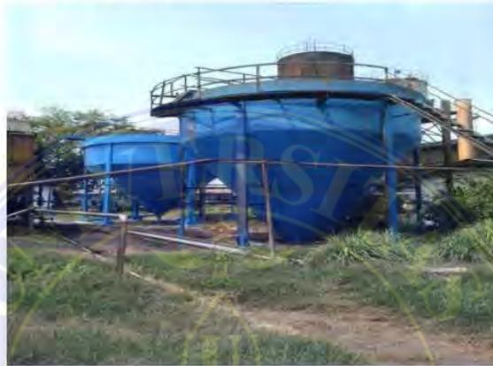
Gambar 3.31. Tangki Pengendapan (*Clarifier tank*)
