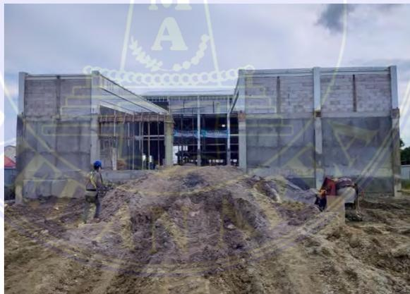
Gambar 3.17 Tanah Timbunan
