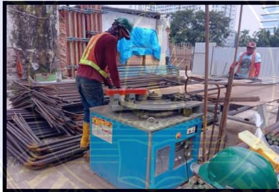
Gambar 3.9 *Bar Bending*
