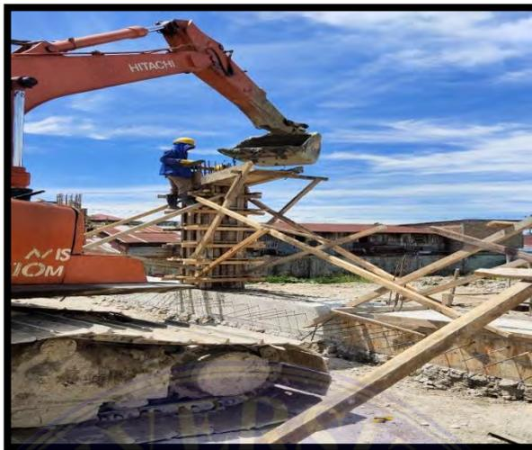
Gambar 4.7 Pengecoran Kolom
