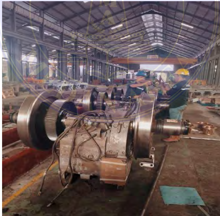
Proses pemasangan penutup gearbox
