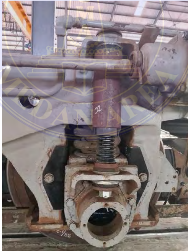
Pemasangan journal bearing
