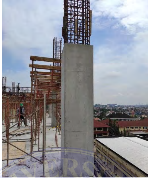
Gambar 4.14. Kolom yang sudah jadi Sumber: Data Lapangan 2023
