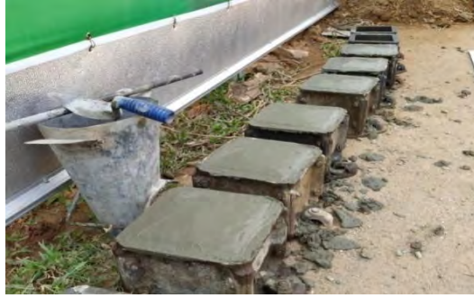
Gambar 4.11. Uji Tes Slump
