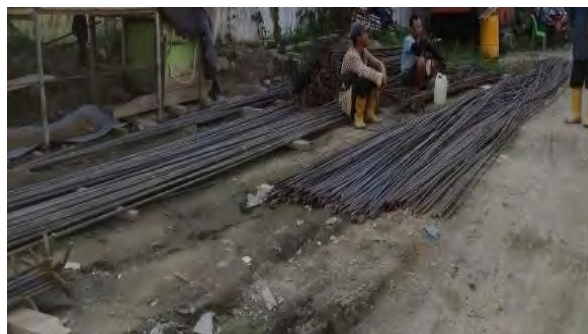
Gambar 2.19 Besi Tulangan Sumber: Data Lapangan 2023
