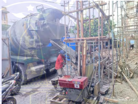
Gambar 4.12. Lift Beton
