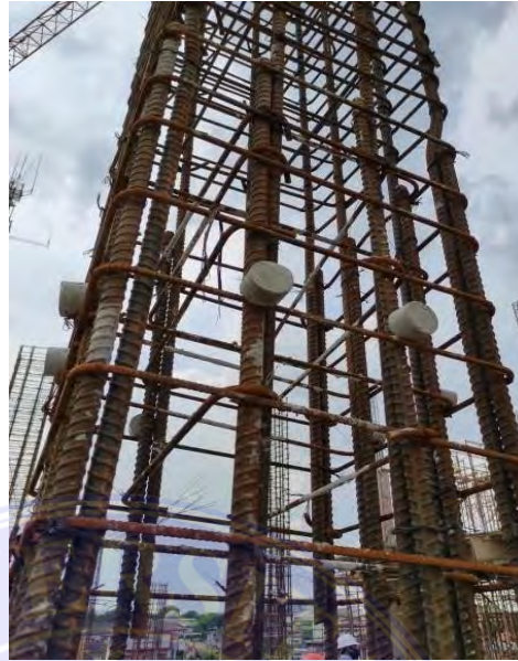
Gambar 4.8. Pemasangan beton decking
