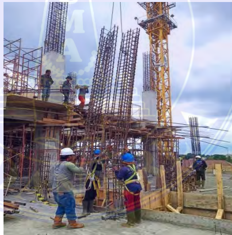
Gambar 4.6. Penyambungan kolom dengan bantuan tower crane Sumber: Data Lapangan 2023
