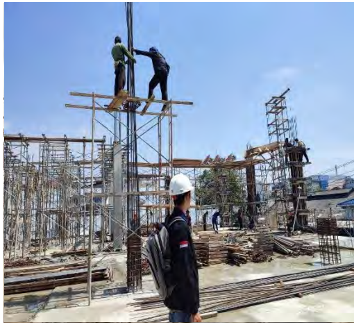
Gambar 4.7. Perakitan tulangan kolom Sumber: Data Lapangan
