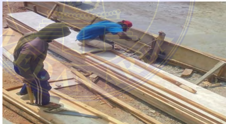
Gambar 4.4. Perakitan Bekisting
