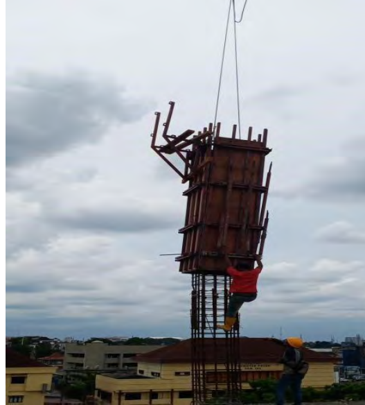
Gambar 4.9. Pemasangan bekisting kolom
