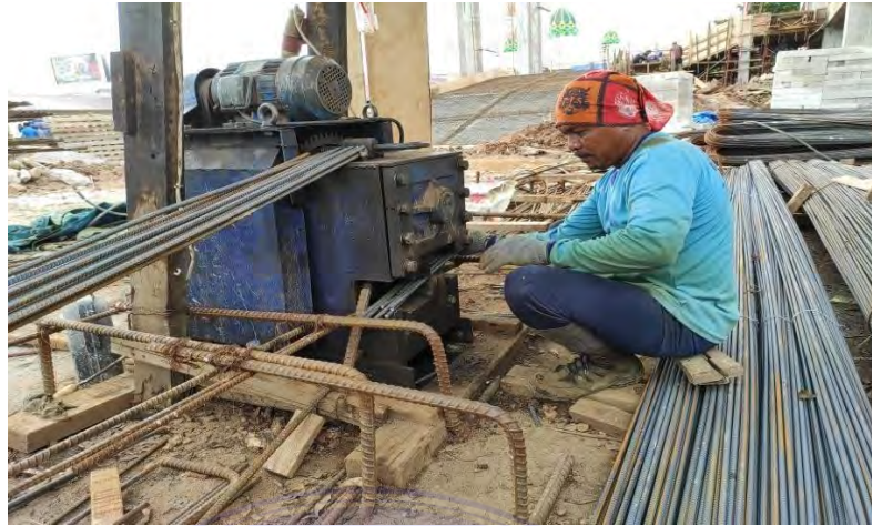
a. Gambar 4.2. Pemotongan besi tulangan b. Sumber: Data Lapangan 2023
