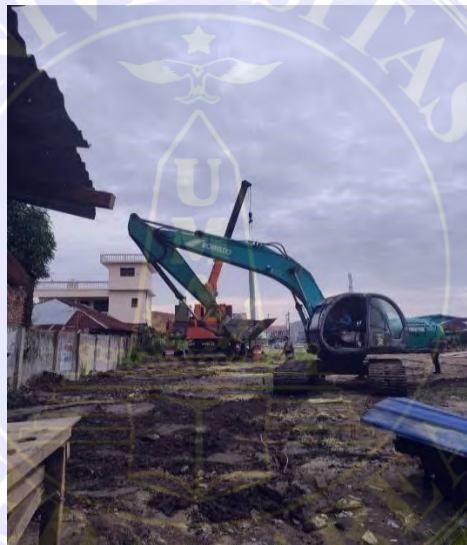
Gambar 2.3 Excavator Sumber: Data Lapangan 2023
