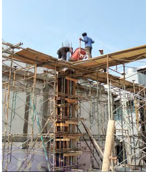
Gambar 4.13. Pengecoran kolom
