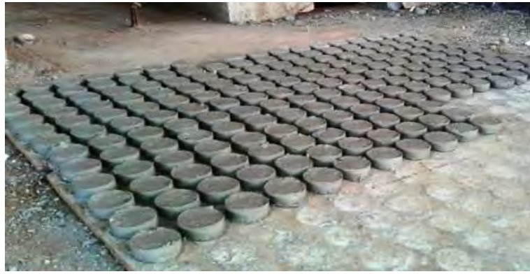
Gambar 4.5. Pembuatan beton decking
