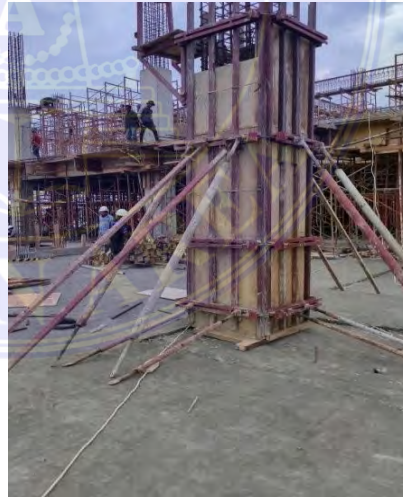
Gambar 4.10. Pemasangan penyangga bekisting
