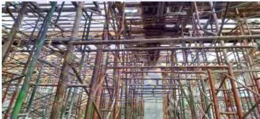
Gambar 4 7 Pemasangan Bekisting
