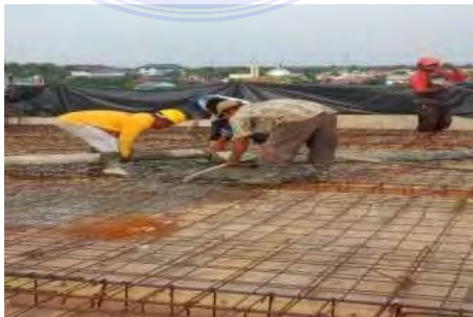
Gambar 4 8 Pengecoran balok
