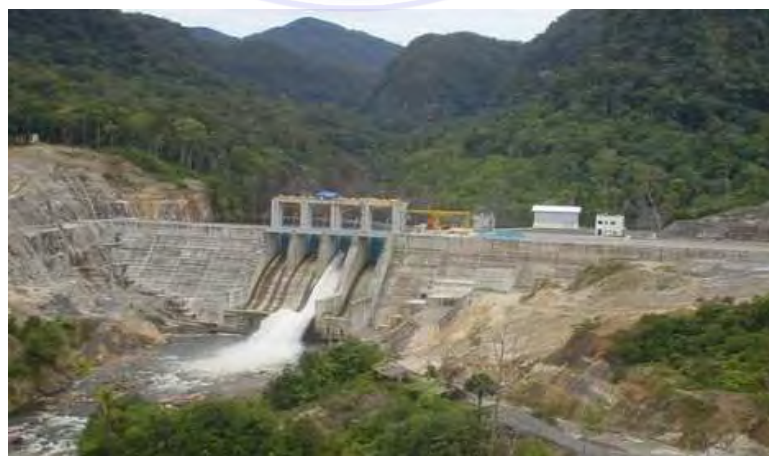
Gambar 3.3. Spillway ULPLTA Sipansihaporas
