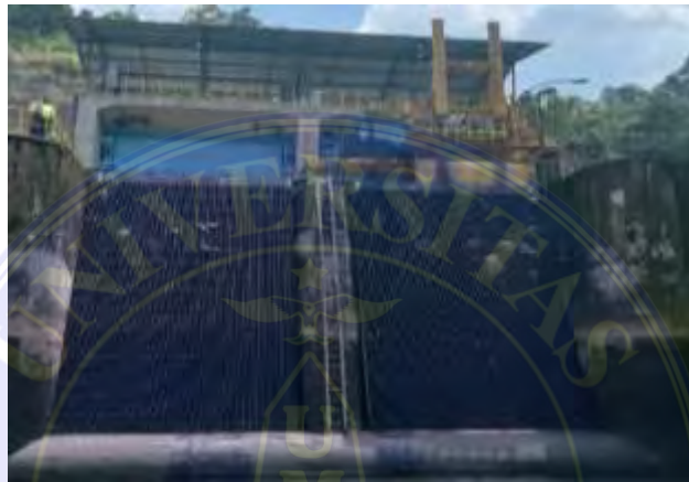
Gambar 3.5. Barscreen ULPLTA sipansihaporas
