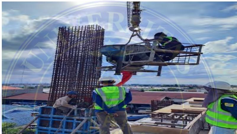
Gambar 4. 4 Pengecoran Kolom
