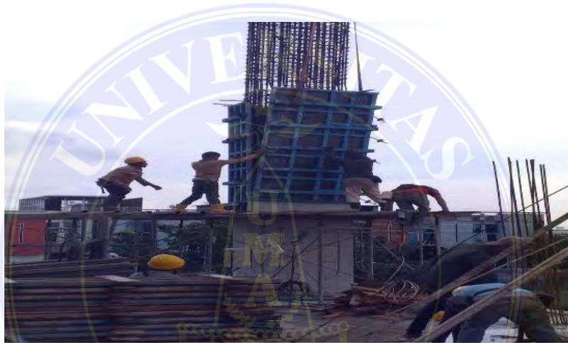
*Gambar 4. 5 Pembongkaran Bekisting Kolom*
