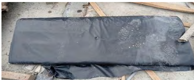
Gambar 3.42 Plastik Cor Sumber : Dokumentasi Proyek, 2024
