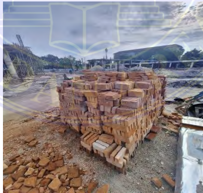
Gambar 3.41 Batu Bata Sumber : Dokumentasi Proyek, 2024
