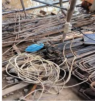
Gambar 3.26 Cok Sambung Sumber : Dokumentasi Proyek, 2024
