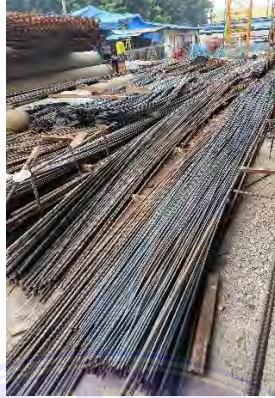
Gambar 3.34 Besi Tulangan Sumber : Dokumentasi Proyek, 2024
