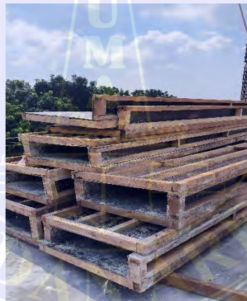
Gambar 3.9 Bekisting Sumber : Dokumentasi Proyek, 2024
