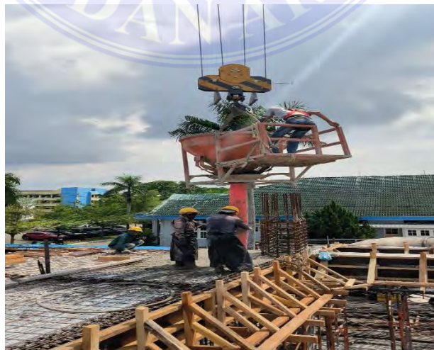
Gambar 4.10 Pengecoran Pelat Lantai dan Balok Sumber : Dokumentasi Proyek, 2024
