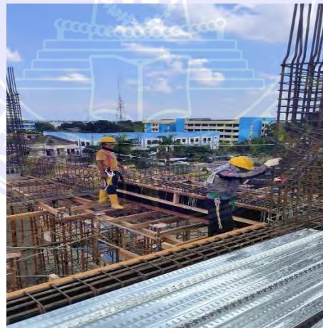
Gambar 4.5 Pemasangan Bekisting Balok Sumber : Dokumentasi Proyek, 2024
