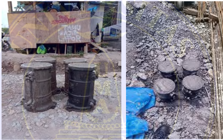
Gambar 4.9 Sample Silinder untuk uji kuat tekan beton Sumber : Dokumentasi Proyek, 2024
