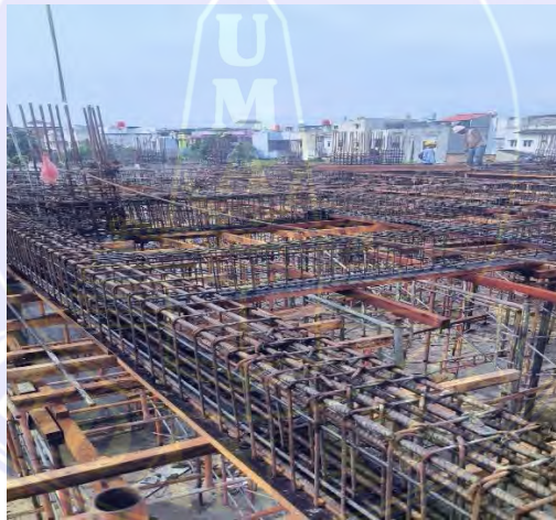
Gambar 4.6 Proses Pembesian Balok Sumber : Dokumentasi Proyek, 2024
