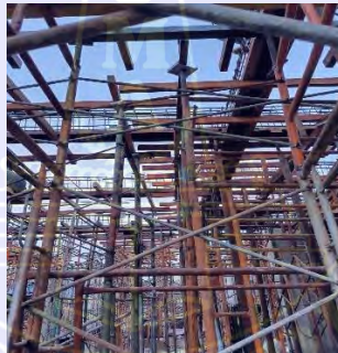
Gambar 3.23 Scaffolding Sumber : Dokumentasi Proyek, 2024
