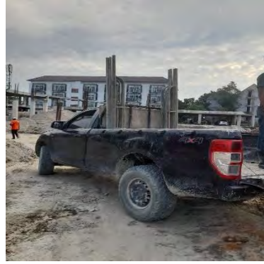
Gambar 3.18 Truk Barang Sumber : Dokumentasi Proyek, 2024
