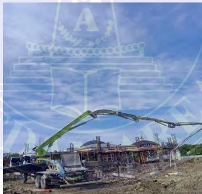
Gambar 3.11 Concrete Pump Sumber : Dokumentasi Proyek, 2024
