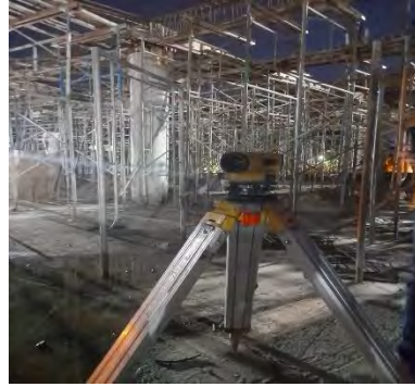
Gambar 3.6 Watterpass Sumber : Dokumentasi Proyek, 2024
