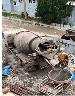
Gambar 3.10 Truck Mixer Beton Sumber : Dokumentasi Proyek, 2024
