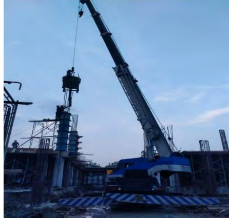
Gambar 3.16 Rough Terrain Crane Sumber : Dokumentasi Proyek, 2024
