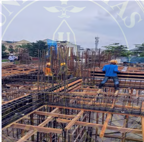
Gambar 4.3 Proses Pembuatan Bekisting Sumber : Dokumentasi Proyek, 2024
