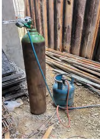
Gambar 3.14 Las Gas Sumber : Dokumentasi Proyek, 2024
