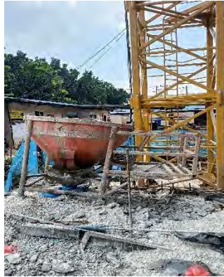
Gambar 3.12 Bucket Cor Sumber : Dokumentasi Proyek, 2024
