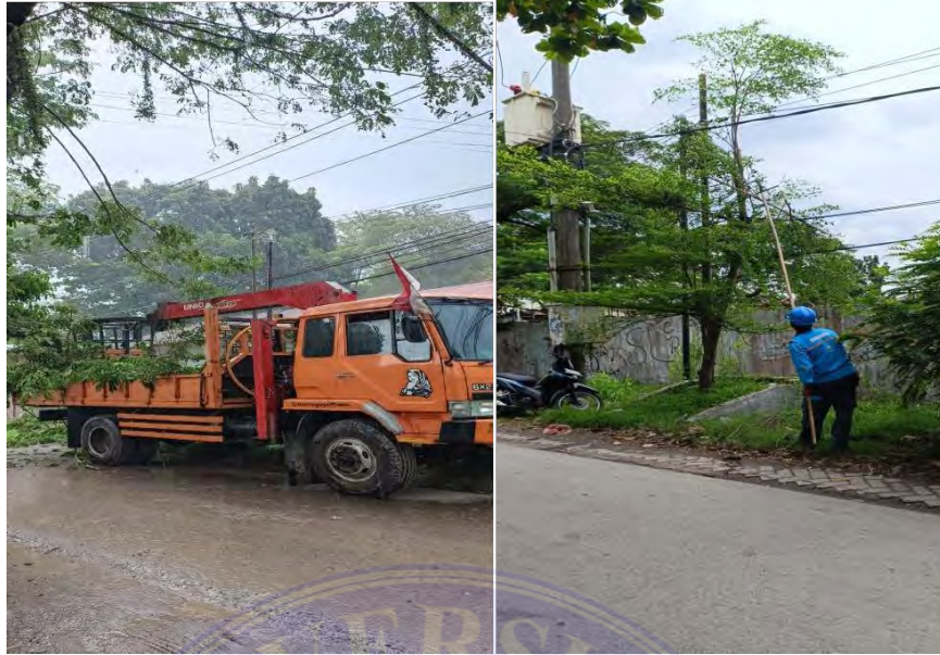
Gambar 7. Pemangkasan pohon mendekati SUTM
