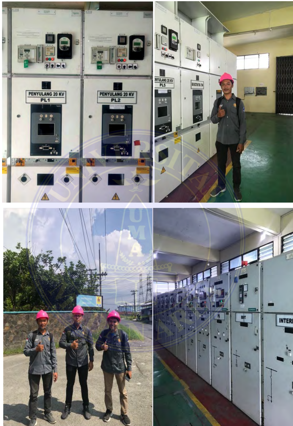
Gambar 1. Perbaikan penyulang pa.2 GI paya geli
