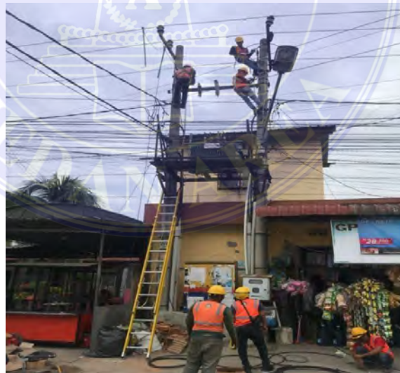
Gambar 2.6 Proses pergantian trafo
