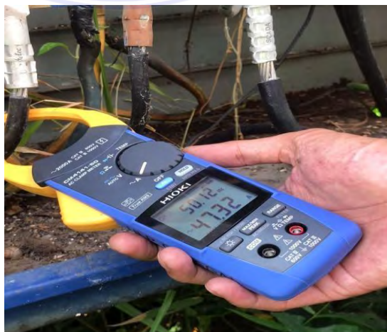
Gambar 3.3 Mengukur arus jurusan trafo
