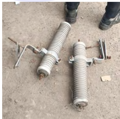
Gambar 2.2 Komponen Lightning Arrester (LA)
