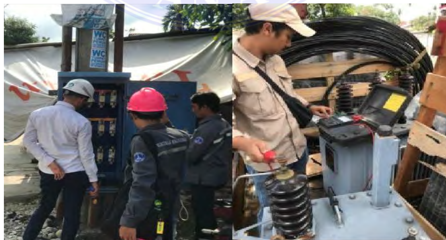
Gambar 4. Pengecekan tahanan isolasi pada trafo
