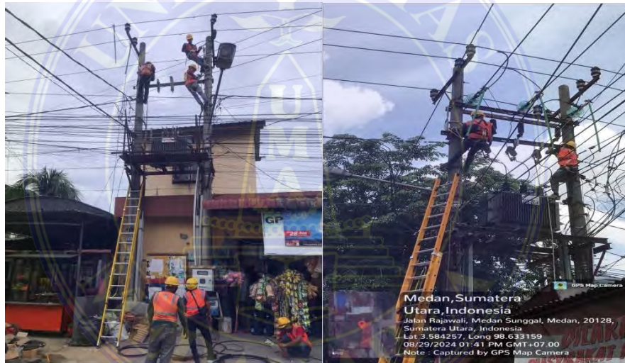
Gambar 8. Penggantian trafo distribusi
