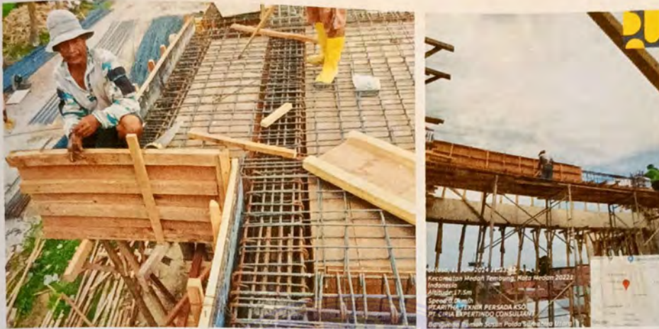
Gambar 4.3 Perakitan Bekisting Balok
