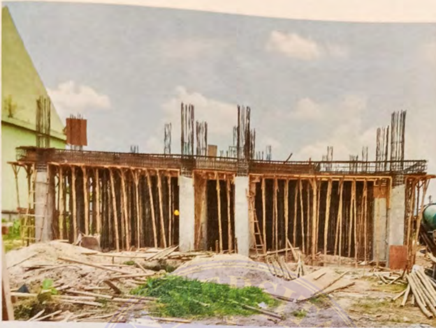
Dokumentasi Lapangan : Progres Pembangunan Rusun bulan ke 3
