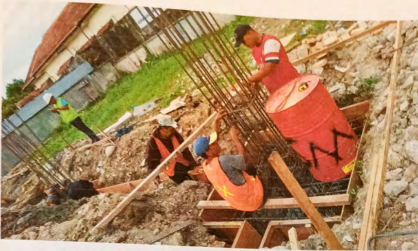
Dokumentasi Lapangan : Progres Pembangunan Rusun bulan ke 1
