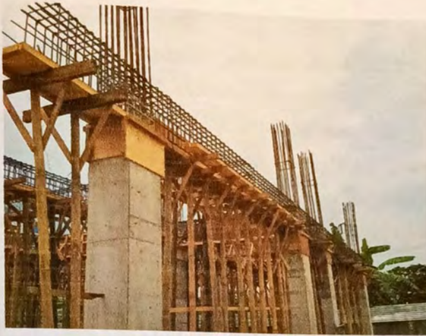
Gambar 4.4 Pengerjaan Penulangan Diatas Bekisting Balok
