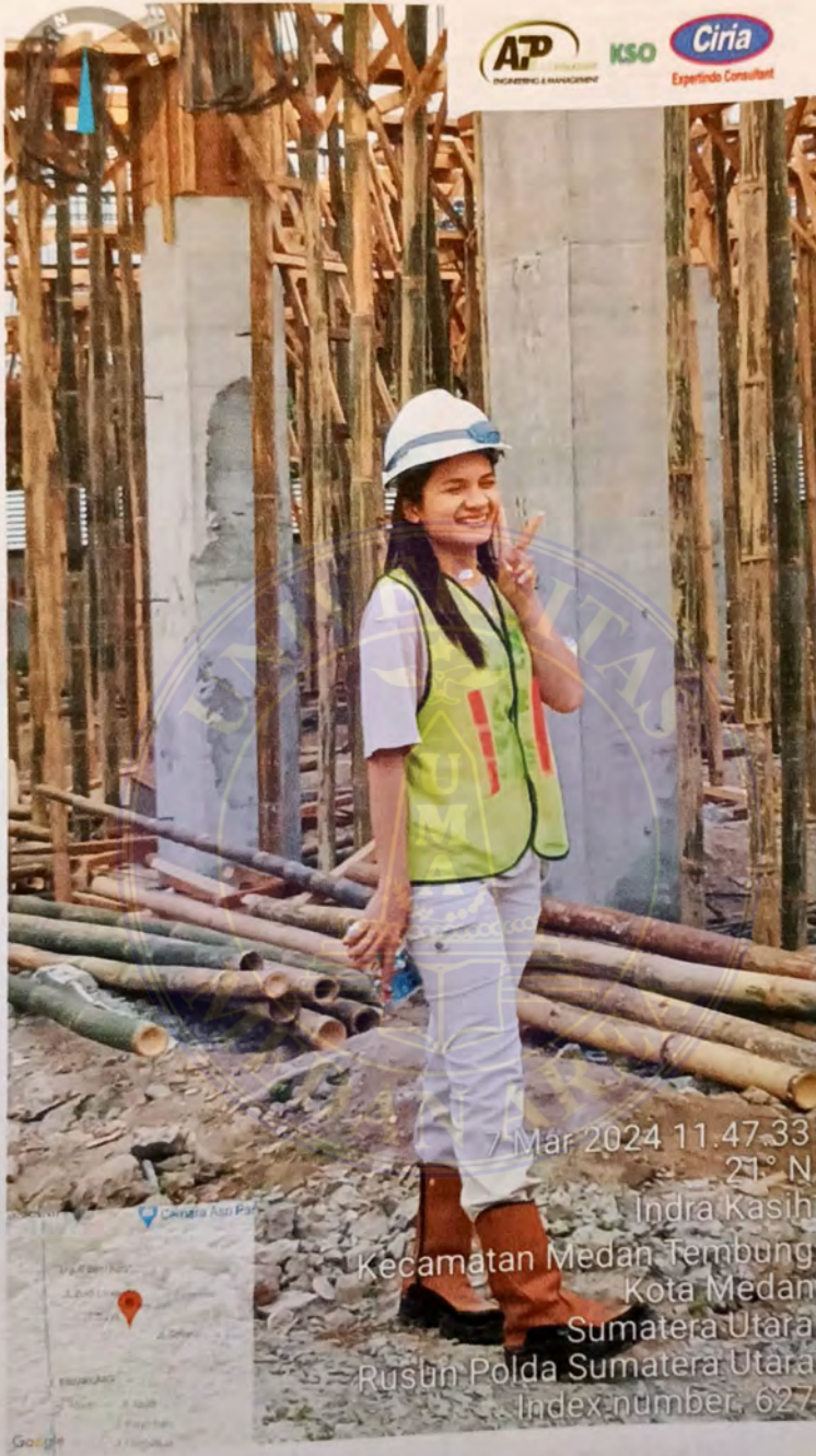
Dokumentasi Lapangan : Meninjau Pekerjaan Proyek
