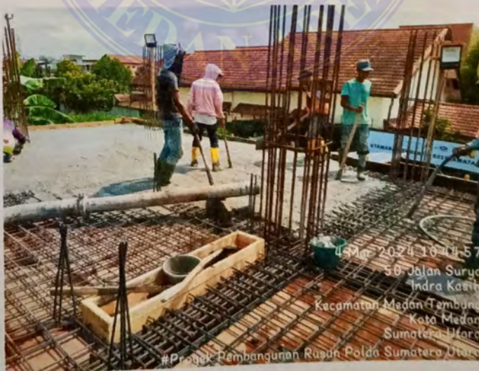
Gambar 4.6 Pengecoran Balok dan Pelat Lantai
