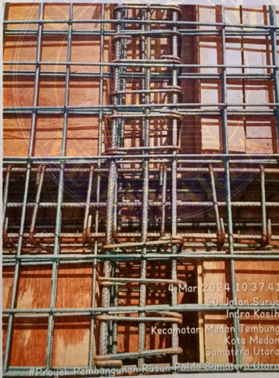
Gambar 4.5 Penulangan Pada Balok Induk dan Balok Anak
