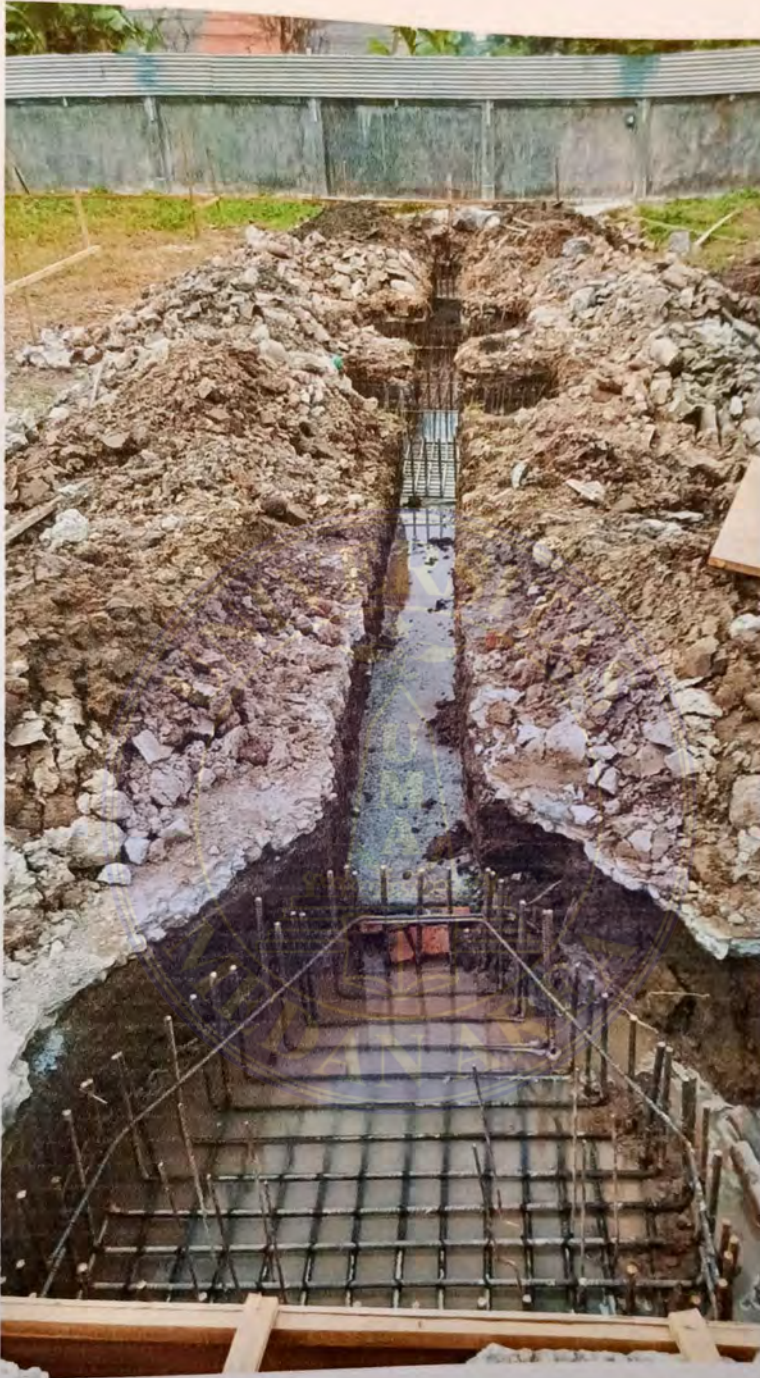
Dokumentasi Lapangan : Pengamatan Progres pekerjaan Pile Cap
