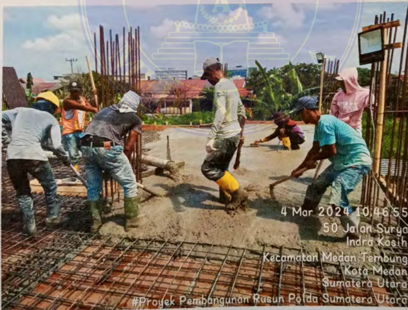
Dokumentasi Lapangan : Pengecoran Balok dan Pelat Lantai 2
