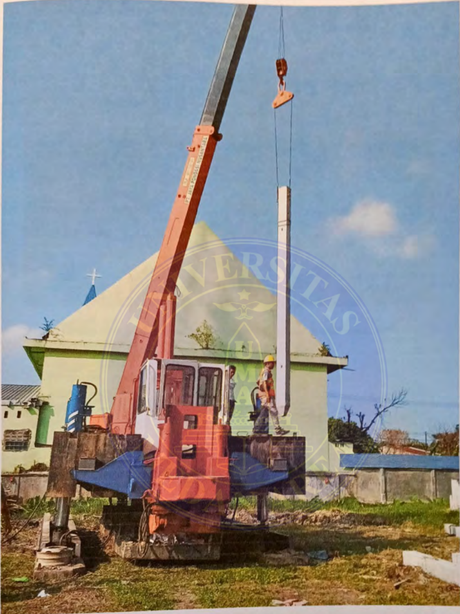
Dokumentasi Lapangan : Pekerjaan Pemancangan tiang pancang menggunakan HSPD
