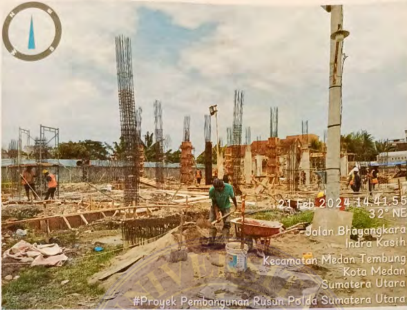
Dokumentasi Lapangan : Progres Pembangunan Rusun bulan ke 2
