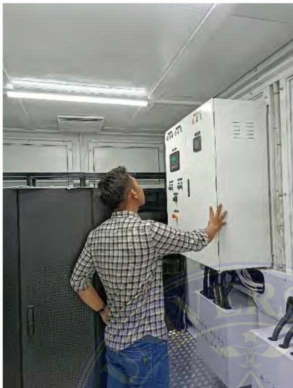
Pemantauan Panel Box Di dalam UPS Mobile 200 KVA yg terletak di sebelah Gedung serbaguna
