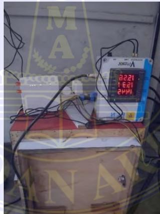
Gambar 3.4 Tegangan Arus UGB 630 Kva
