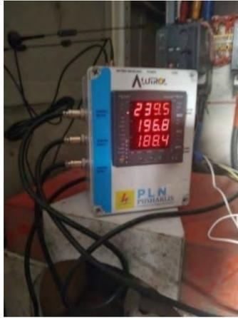
Gambar 3.3 Tegangan Gedung Serbaguna Trafo 400 kVA
