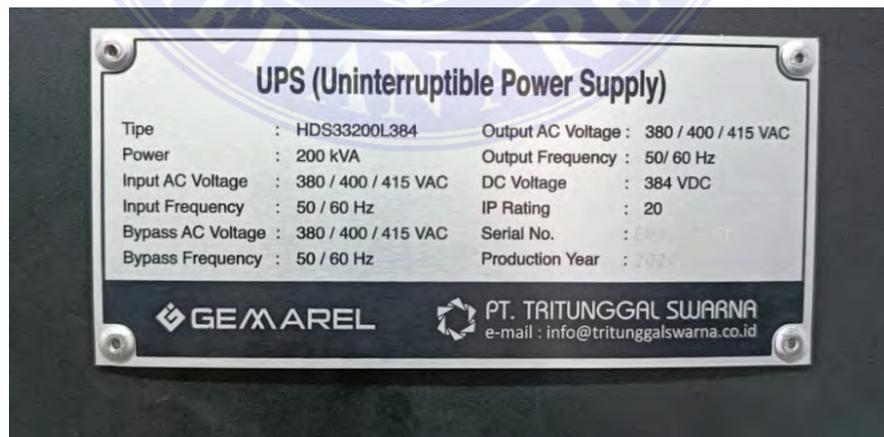
Gambar 4.2 Spesifikasi UPS Mobile 200 KVA
