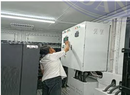
Pengeckkan Tegangan, arus dan daya baterai di UPS
