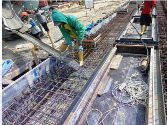
Gambar 4.6 Pengecoran Plat Lantai
