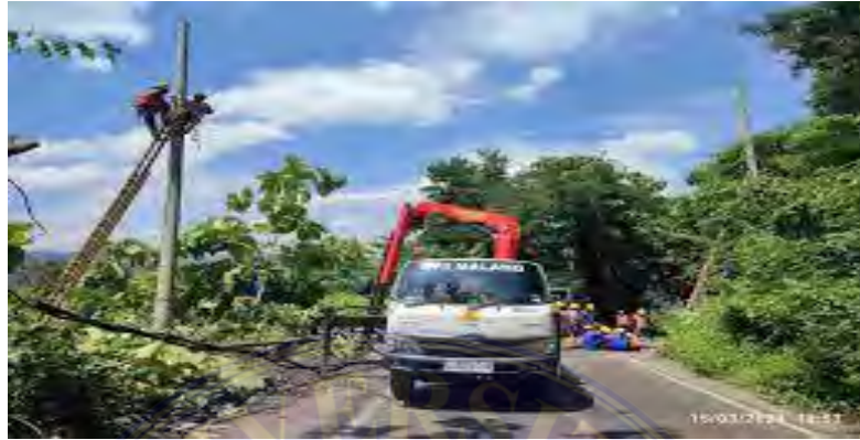
Gambar 3.3 perbaikan JTR akibat cuaca ekstrim
