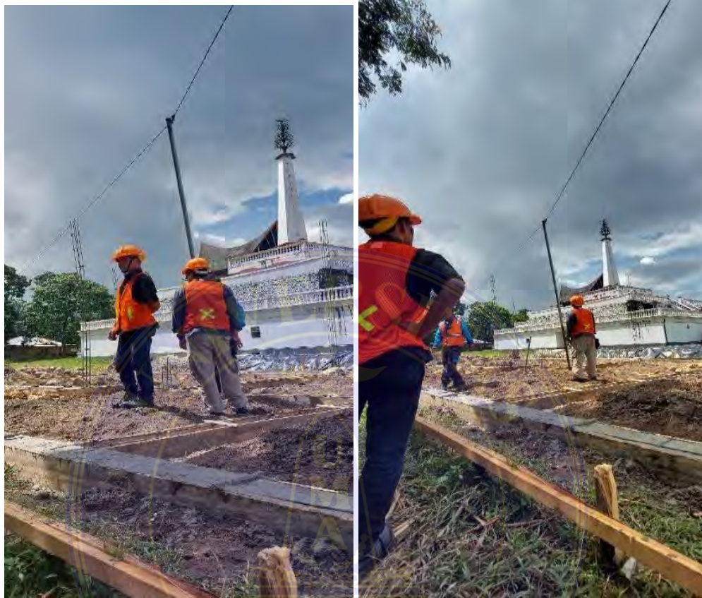
Gambar 3.5 penggantian kabel SR
