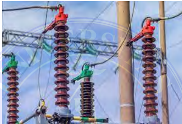
Gambar 2.2 Isolator porselen atau polimer
