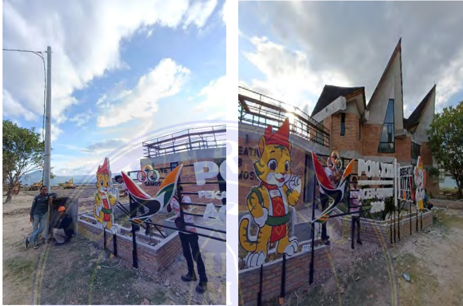
Gambar 3.6 proses pembuatan instalasi penerangan PON XXI
