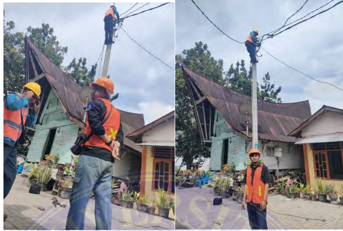
Gambar 3.1 perawatan kabel JTR
