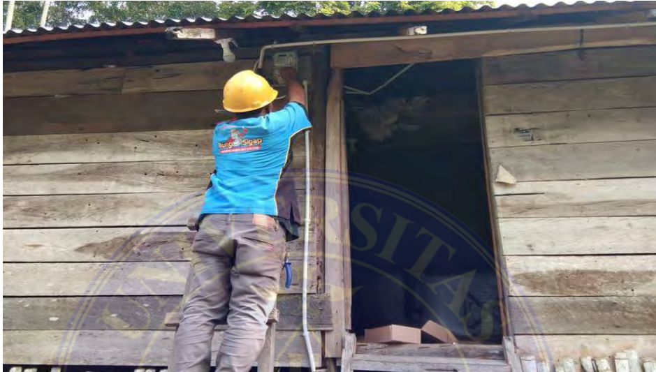
Gambar 3.2 Perbaikan MCB
