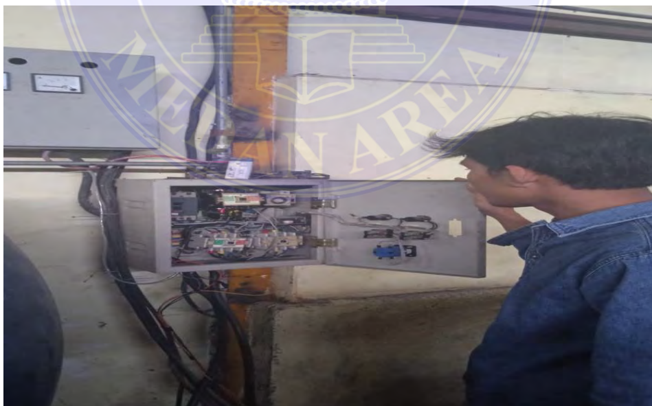
Gambar 5.2: panel kontrol pada motor listrik
