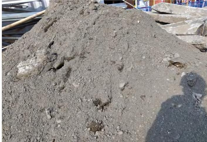
Gambar 3.1 Agregat halus (pasir)
