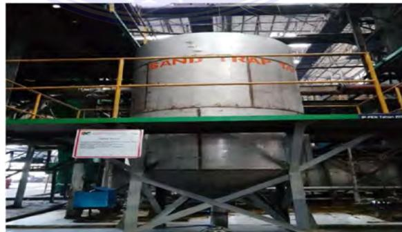
Gambar 3. 24. Sand Trap Tank
