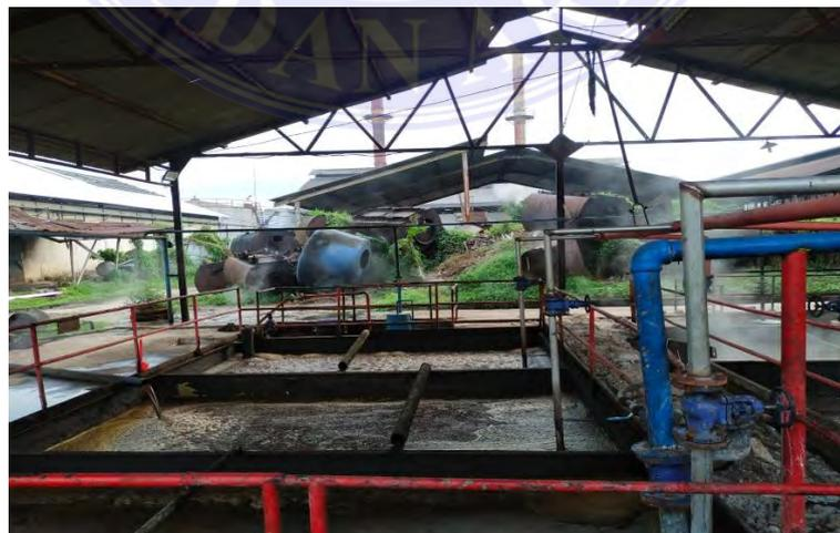
Gambar 3.32. Bak Penampung *Sludge (Fat Fit)*
