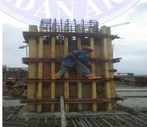
Gambar 4.5 Pemasangan Bekisting Kolom disisi kanan dan kiri
