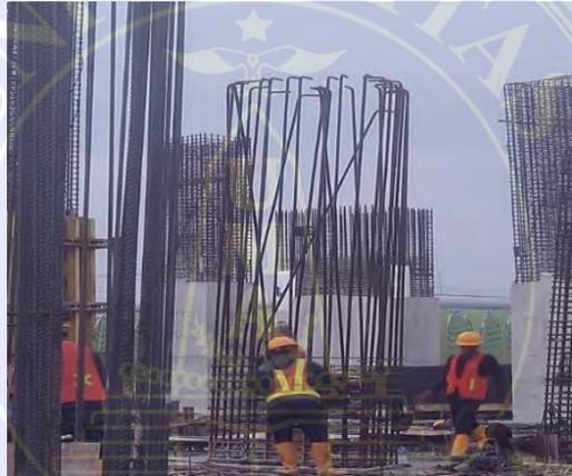
Gambar 4.4 Pemasangan Tapak Kolom
