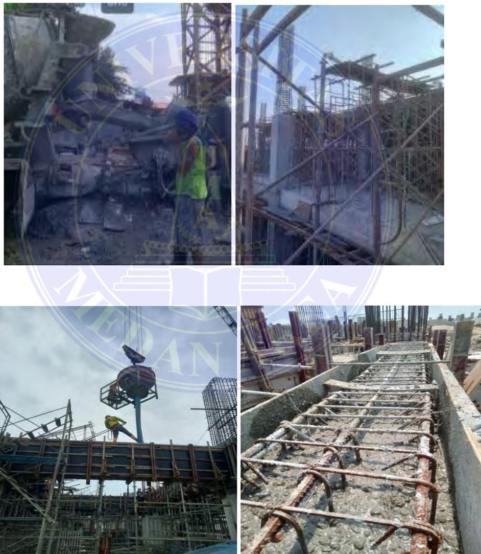
Gambar 4.10 Pengecoran Kolom
