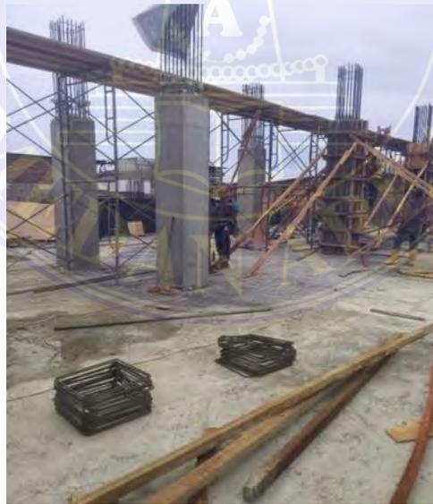
Gambar 4.11 Pelepasan Bekisting dan Perancah
