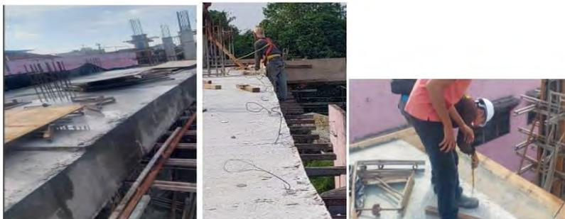
Gambar 4.10 Pelepasan Bekisting Balok
