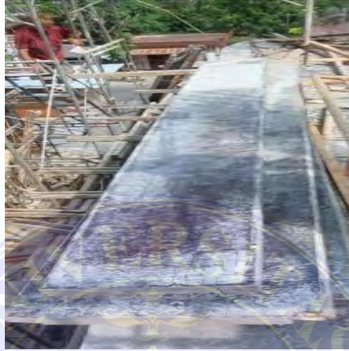
Gambar 3.9 Bekisting(Kolom dan Balok)
