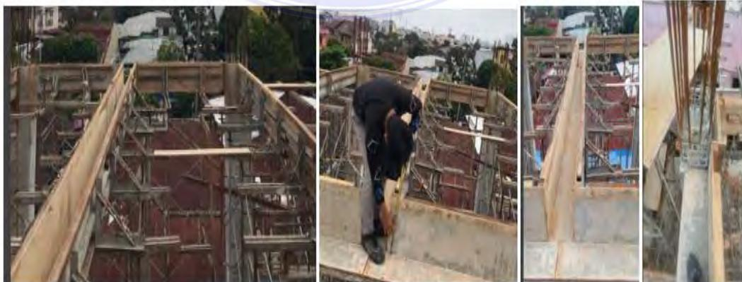
Gambar 4.7 Pembuatan Bekisting Balok
