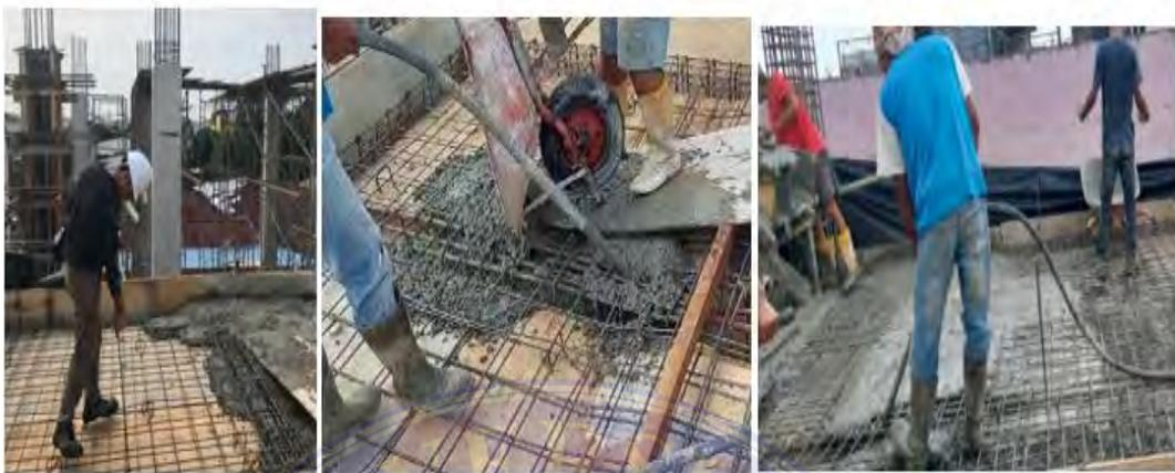
Gambar 4.9 Pengecoran Balok
