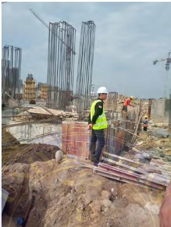
Gambar. Pembongkaran Bekisting
