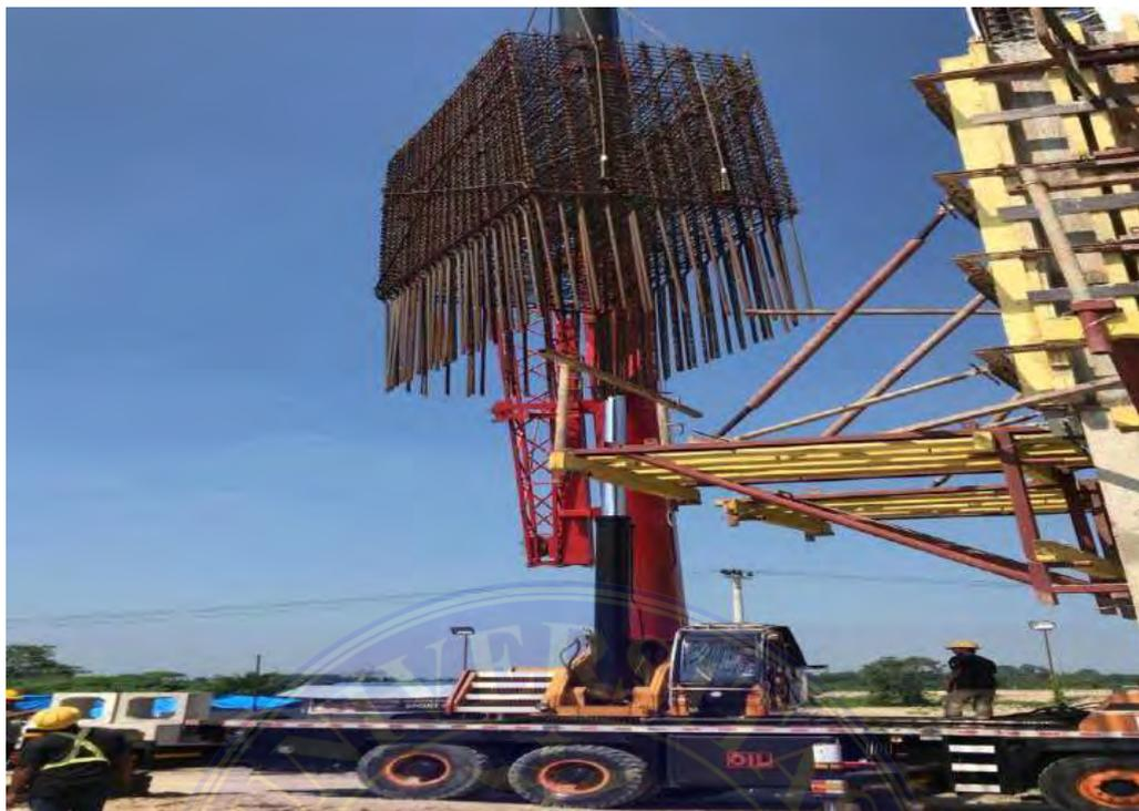
Gambar. Pemasangan Kolom
