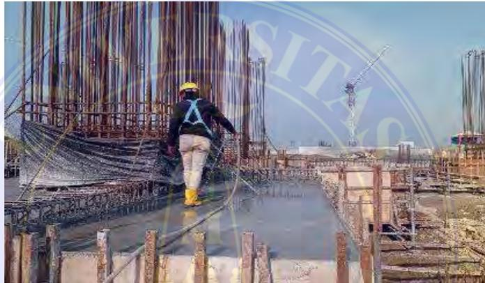
Gambar 50. Perawatan beton *pile cap*
