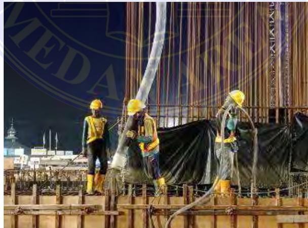
Gambar 49. Pengecoran *pile cap*
