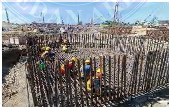
Gambar 47. Pemasangan tulangan *pile cap*
