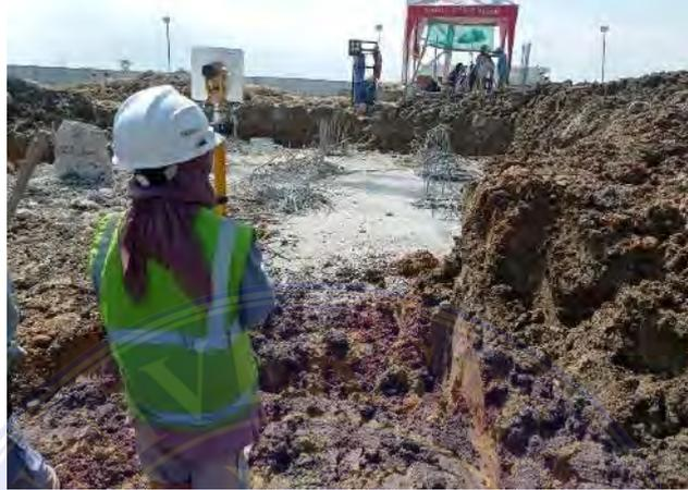
Gambar 43. Pengukuran elevasi *pile cap*
