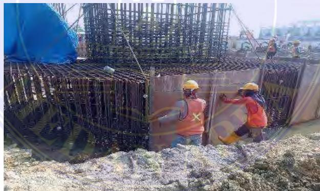
Gambar 48. Pemasangan *bekisting pile cap*
