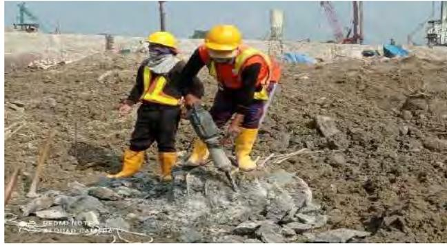
Gambar 45. Pembobokan tiang *bore pile*
