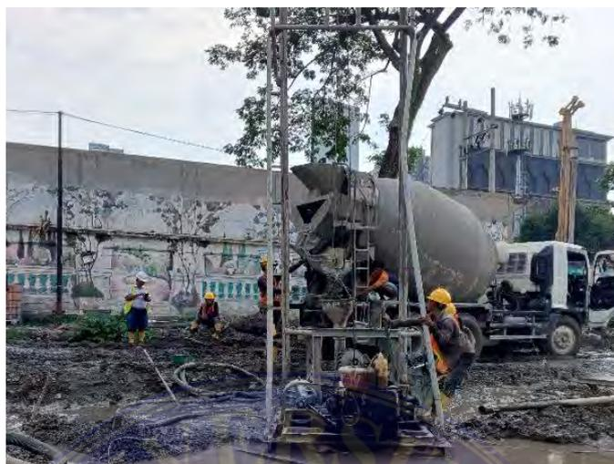
**Gambar 4.6** Pengeboran dan Pengangkatan Tanah
