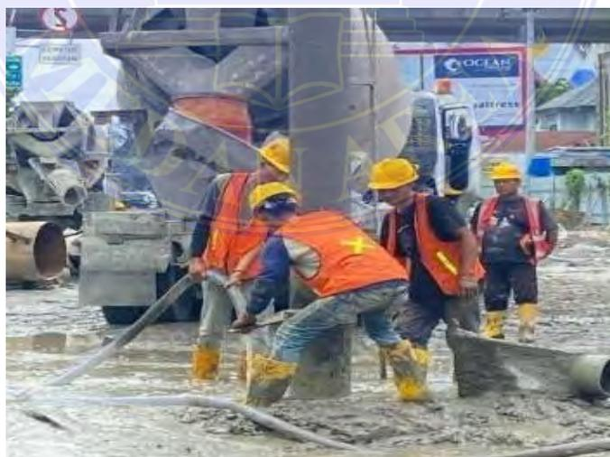
**Gambar 4.12** Proses Pencabutan Pipa Tremi
