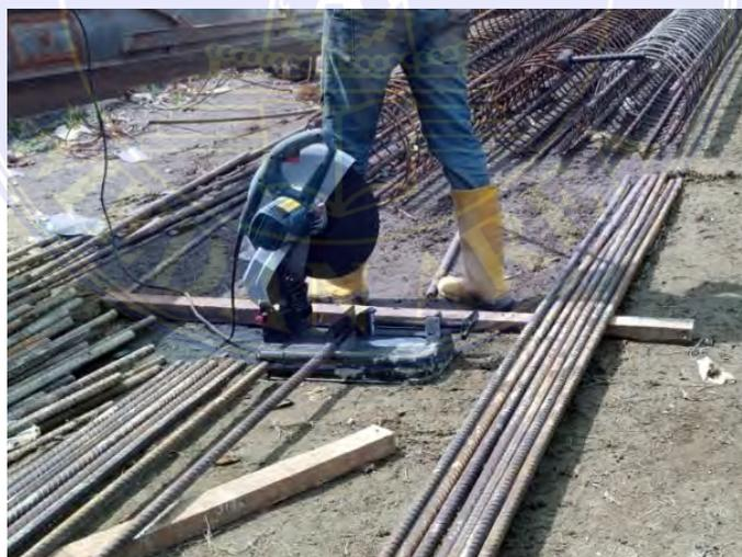
**Gambar 3.7** Mesin Potong Besi (*Cut Off Machine*)
