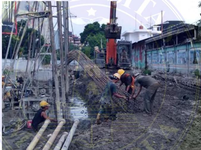
**Gambar 4.8** Proses memasukkan keranjang besi
