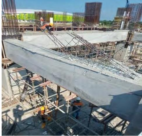
Gambar 4.11 Pelepasan Bekisting dan Perancah
