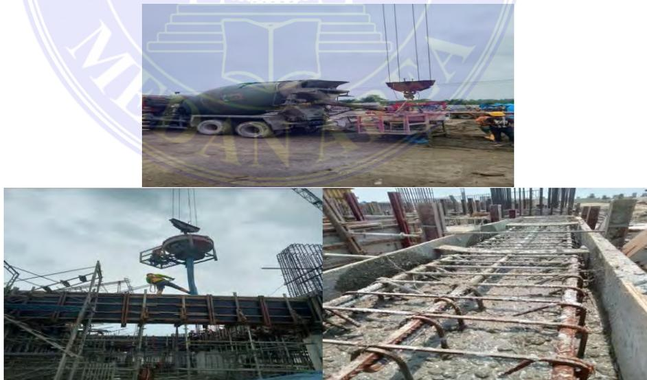
Gambar 4.7 Proses Pengecoran Balok
