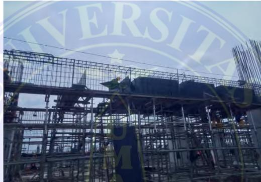
Gambar 4.4 Pemasangan Tapak Balok
