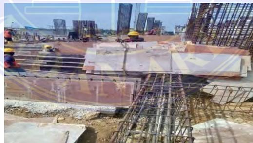
Gambar 4.5 Pemasangan Bekisting Balok disisi kanan dan kiri
