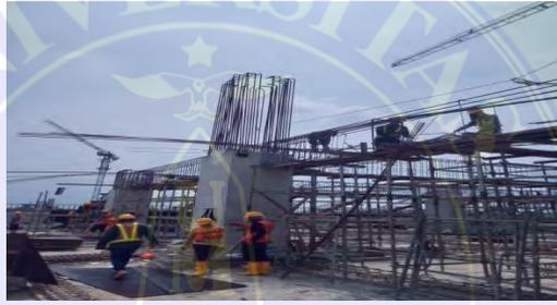
Gambar 4.6 Proses Pembesian Balok
