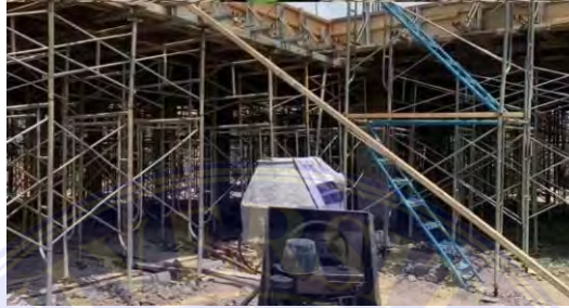
Gambar 4.1 Pemasangan Perancah dan Besi Hollow
