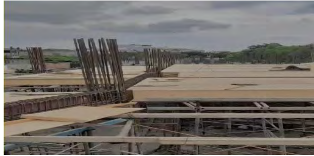
Gambar 4.2 Pemasangan Multiplex
