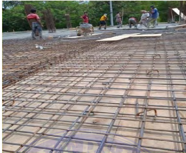
Gambar 4.3 Pemasangan Wiremesh
