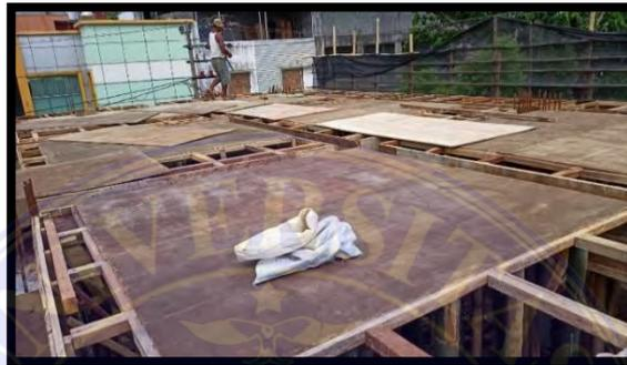
*Gambar 4.3 2 Pemasangan Bekisting Balok dan Plat Lantai*
