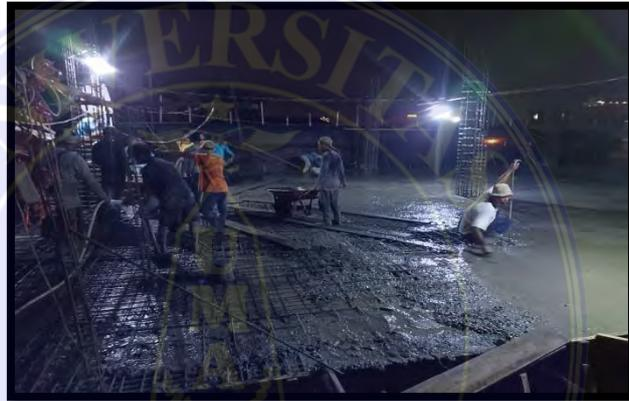
*Gambar 4.3 4 Pengecoran Plat Lantai*
