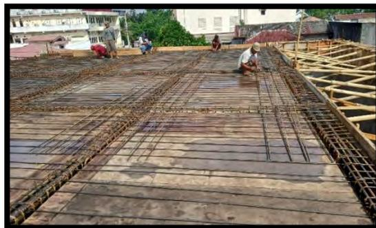
*Gambar 4.3 3 Pemasangan Tulangan Plat Lantai dan Balok*
