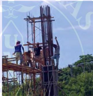
Gambar 4.13 Pengecoran Kolom
