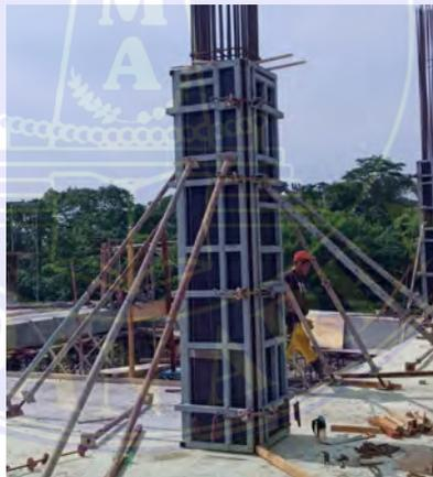
Gambar 4.9 Pemasangan Bekisting Kolom
