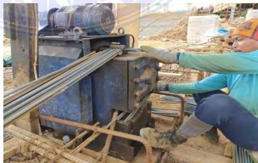
Gambar 3.7 Mesin Pemotong Tulangan (*Bar Cutting*)
