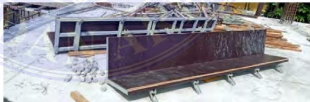
Gambar 4.4 Perakitan Bekisting Kolom
