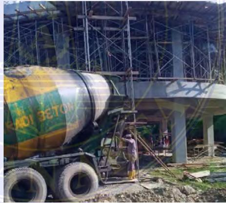
Gambar 4.11 Pemindahan beton *ready mix* ke *concrete bucket*
