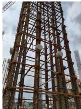
Gambar 4.8 Pemasangan Beton Decking
