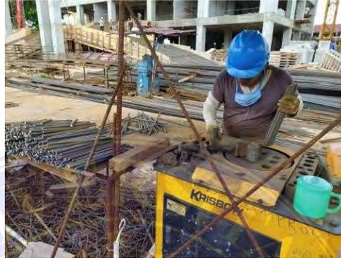
Gambar 3.8 Mesin Pembengkok Tulangan (*Bar Bending*)
