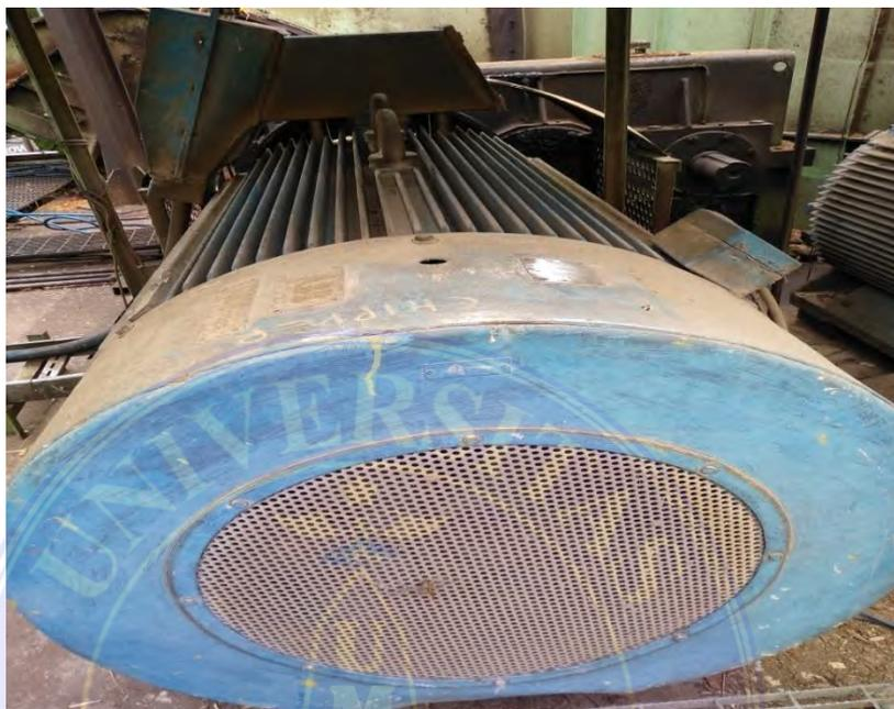
Gambar 17 Motor Yang Menggunakan *Starting* Dengan *Autotransformator*
