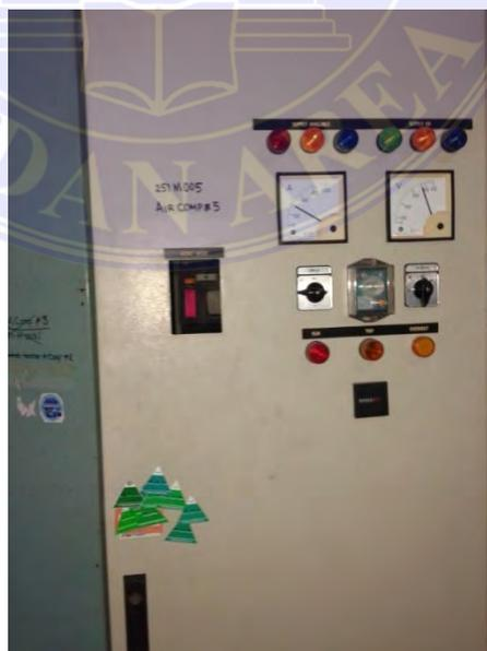
Gambar 18 Lemari Kontrol *Starting* Dengan *Autotransformator*
