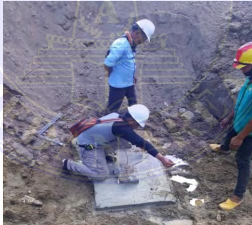
Gambar 4.9 Pendimensian atau Marking Pada Lantai Kerja
