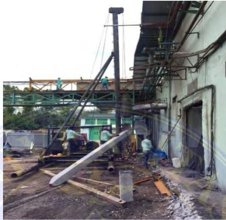
Gambar 4.2 Proses Pengangkatan Tiang Pancang
