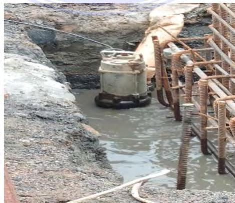
Gambar 4.14 Pekerjaan *Dewatering*
