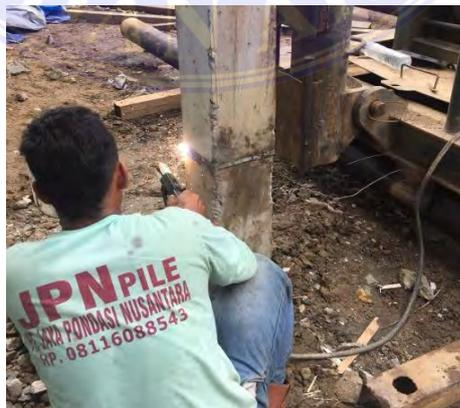
Gambar 4.3 Proses Penyambungan
