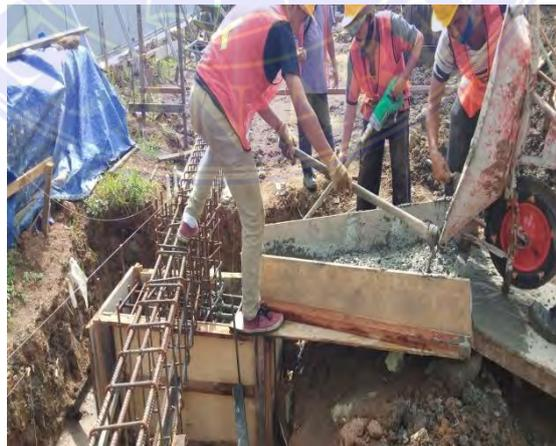
Gambar : 4.15 Pengcoran *Pile Cap*
