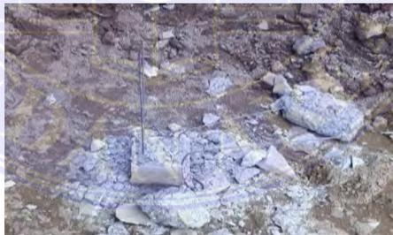
Gambar 4.5 Pemotongan Tiang Pancang
