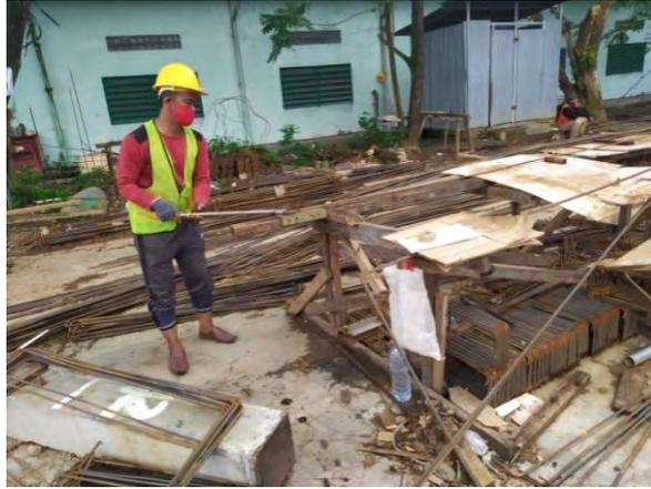
Gambar 3.7 *Bar Bending*
