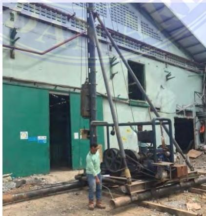
Gambar 4.1 Proses Penempatan *Drop Hammer*
