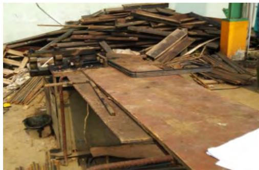
Gambar 4.11 Pemotongan dan Pembengkokan Tulangan
