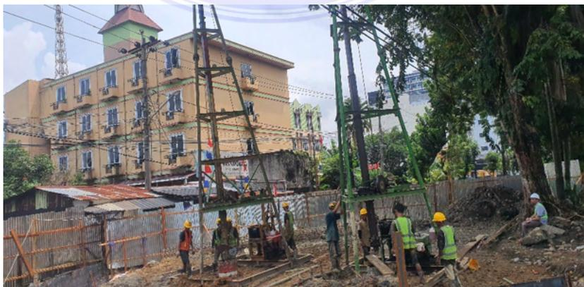
Gambar 4.4 Pekerjaan *Bored pile*
