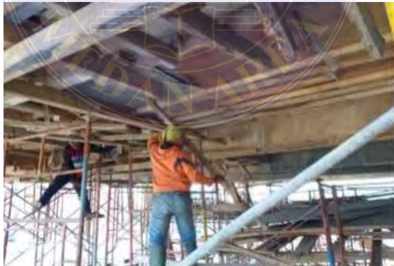
Gambar 4. 7 Pembongkaran Bekisting Sumber: Dokumentasi proyek, 2024
