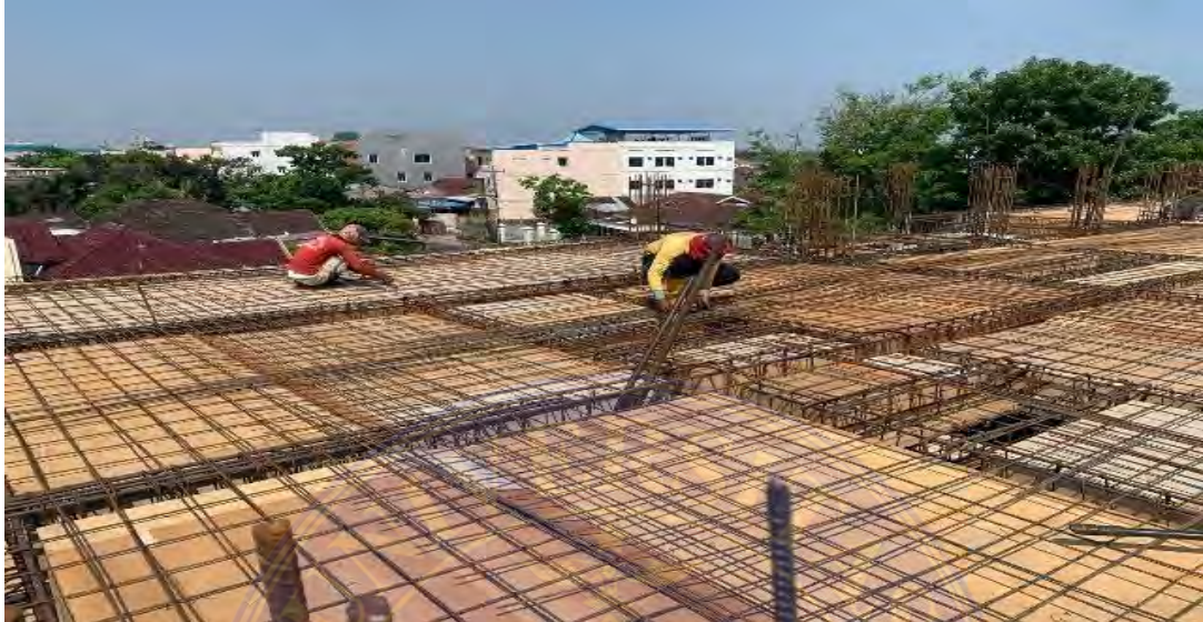
Gambar 4. 4 Perakitan Besi Tulangan Sumber: Dokumentasi proyek, 2024
