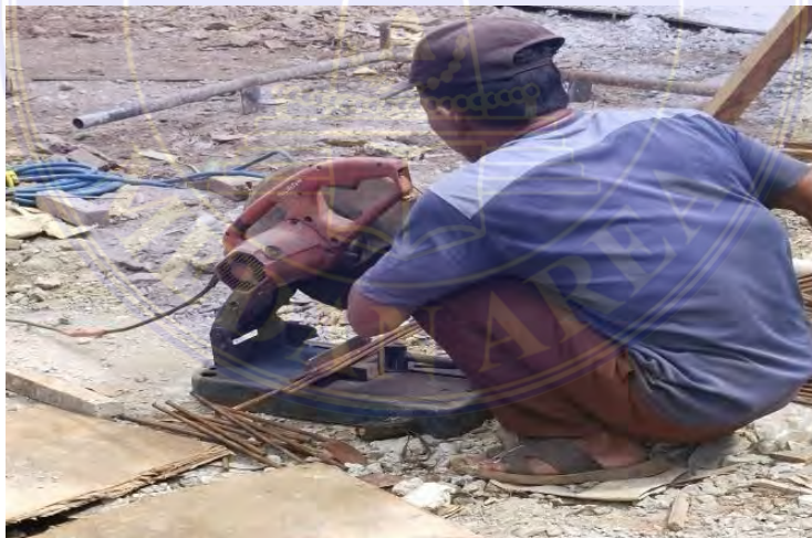
Gambar 4. 3 Pemotongan Besi Tulangan Sumber: Dokumentasi proyek, 2024
