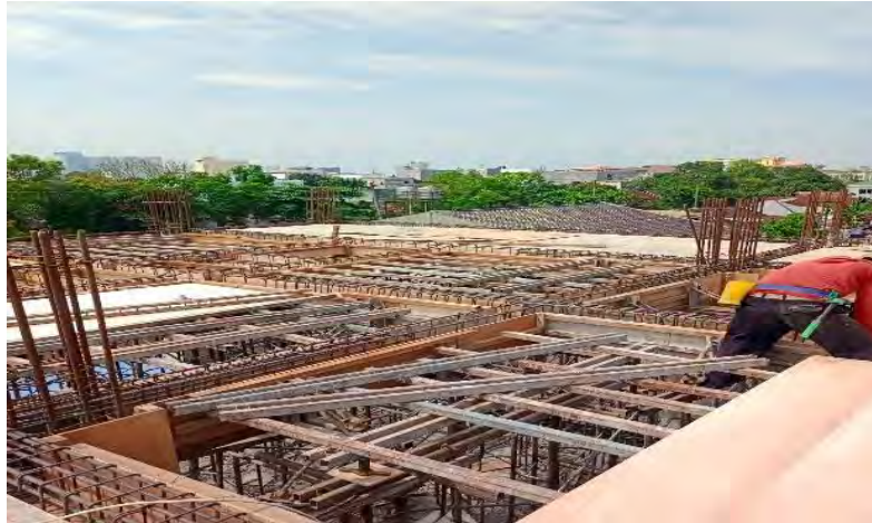
Gambar 4. 2 Pemasangan Bekisting Sumber: Dokumentasi proyek, 2024
