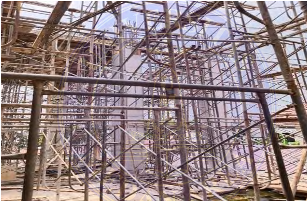
Gambar 4. 1 Pemasangan Scaffolding Sumber: Dokumentasi proyek, 2024
