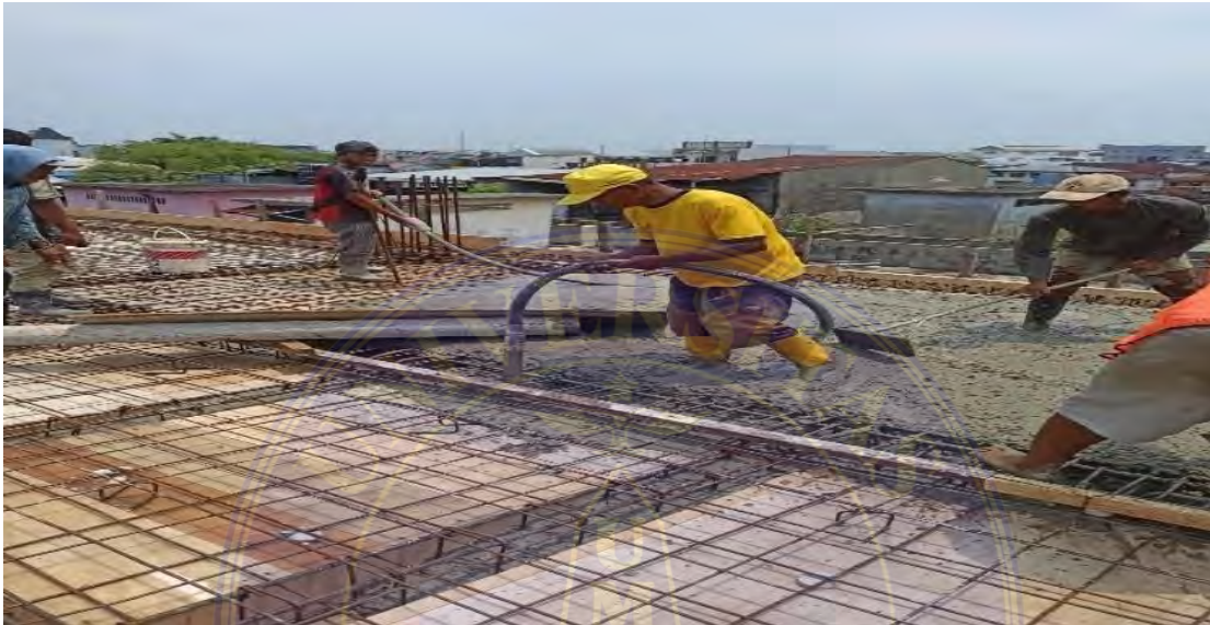
Gambar 4. 6 Pengecoran Pelat Lantai Sumber: Dokumentasi proyek, 2024
