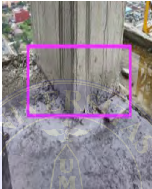
Gambar 3.24 Kondisi Kolom Kropos
