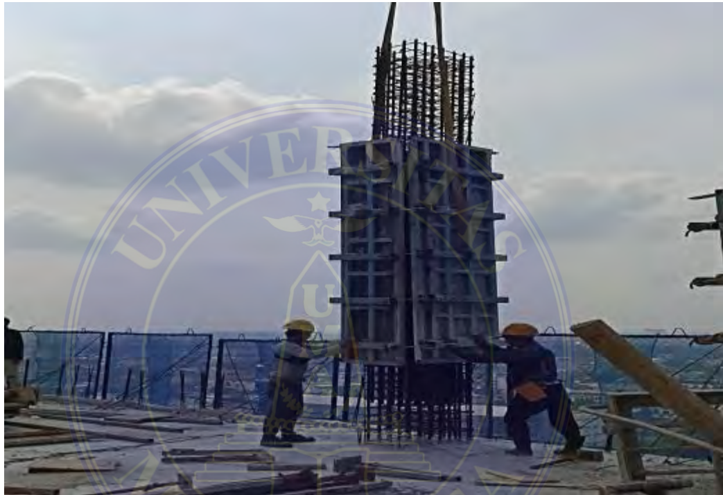
Gambar 4.2 Pemasangan Bekisting
