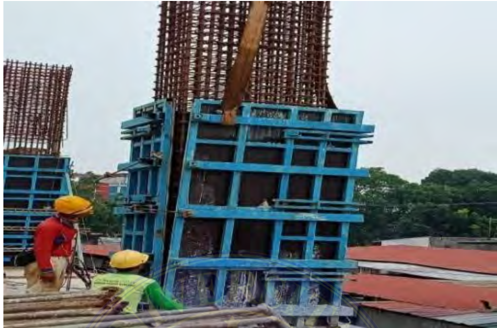
Gambar 3 Pemasangan Begesting Kolom
