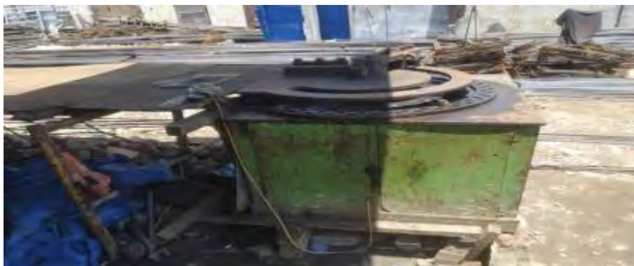
Gambar 3. 9 Pembengkokan Tulangan ( Bar Bender )
