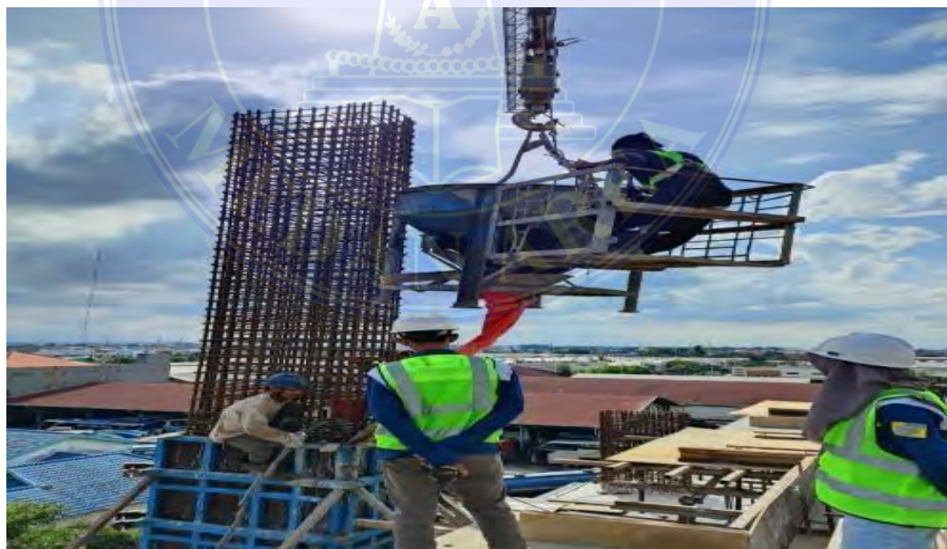
Gambar 4 Pengecoran Kolom
