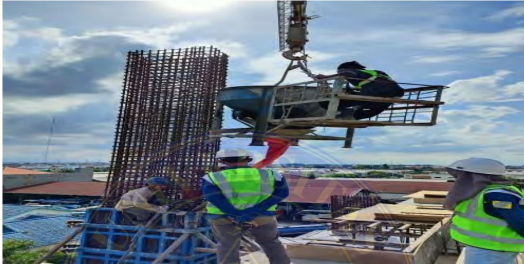
Gambar 3.22 Pengecoran Kolom
