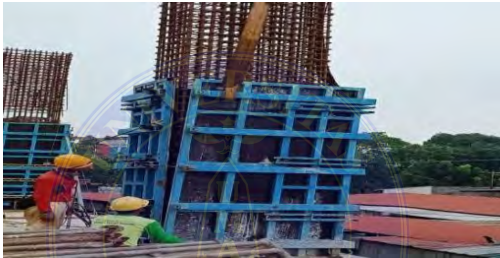
Gambar 3.21 Pemasangan Bekisting Kolom
