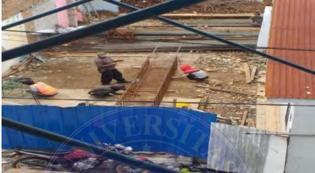
Gambar 1 Perakitan Besi Tulangan kolom
