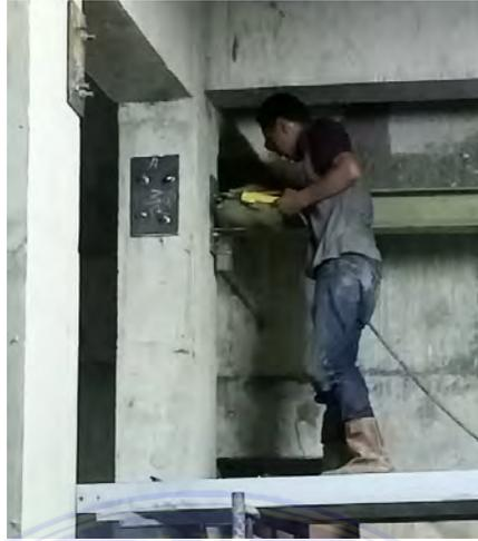
Gambar 4.5 Pemasangan *H-Beam*
