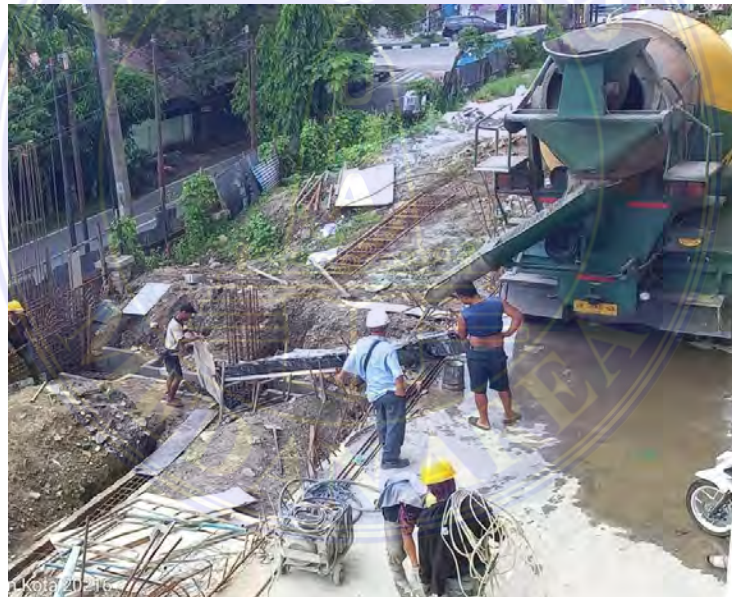
Gambar 4.4 Pekerjaan Pengecoran Pilecap Sumber: Dokumentasi Proyek ,2024
