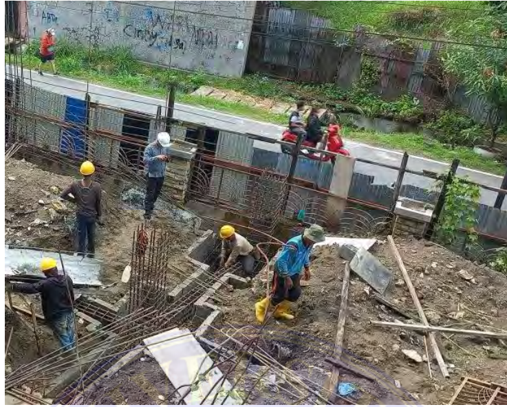
Gambar 4.3 Pekerjaan Penulangan Pilecap Sumber: Dokumentasi Proyek ,2024
