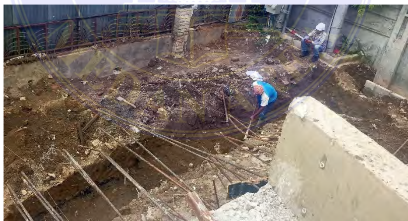
Gambar 4.2 Pekerjaan Penggalan Tanah
