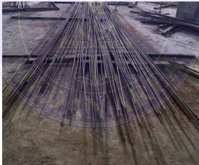
Gambar 2.5 Besi Tulangan Sumber: Dokumentasi Proyek ,2024
