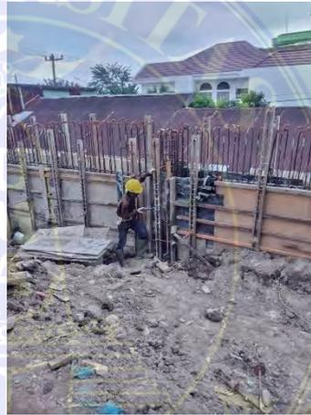
Gambar 4.4.5 Pemasangan bekisting kolom
