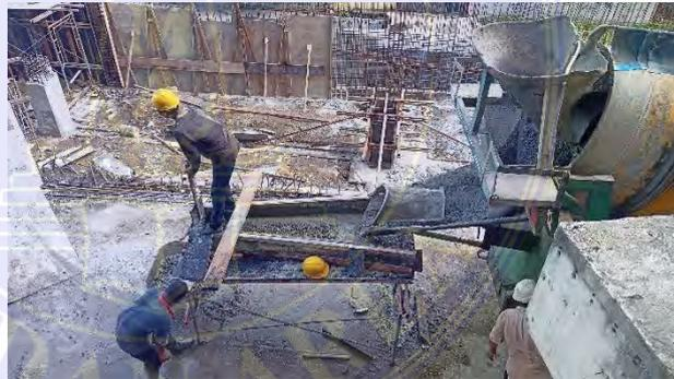
Gambar 4.4.8 Pemindahan beton *Ready Mix* ke *Concrete Bucket*
