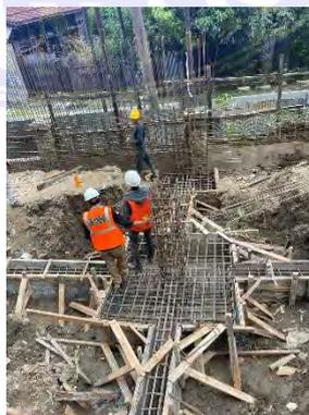
Gambar 3. Pemasangan tulangan kolom & dinding
