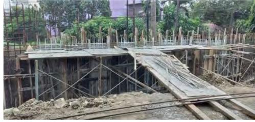
Gambar 4.4.6 Pemasangan Penyanggah bekisting
