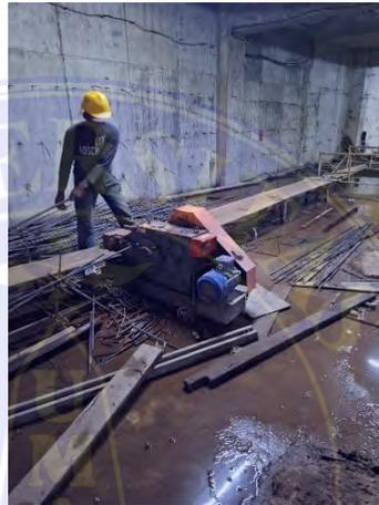
Gambar 4.4.1 Pemotongan besi tulangan
