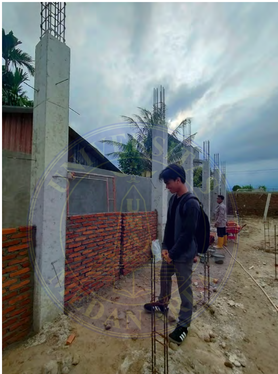
Gambar 3.3. Pengawasan Tahap Pemasangan Bata Untuk Dinding Luar Dengan Ketinggian 1 Meter
