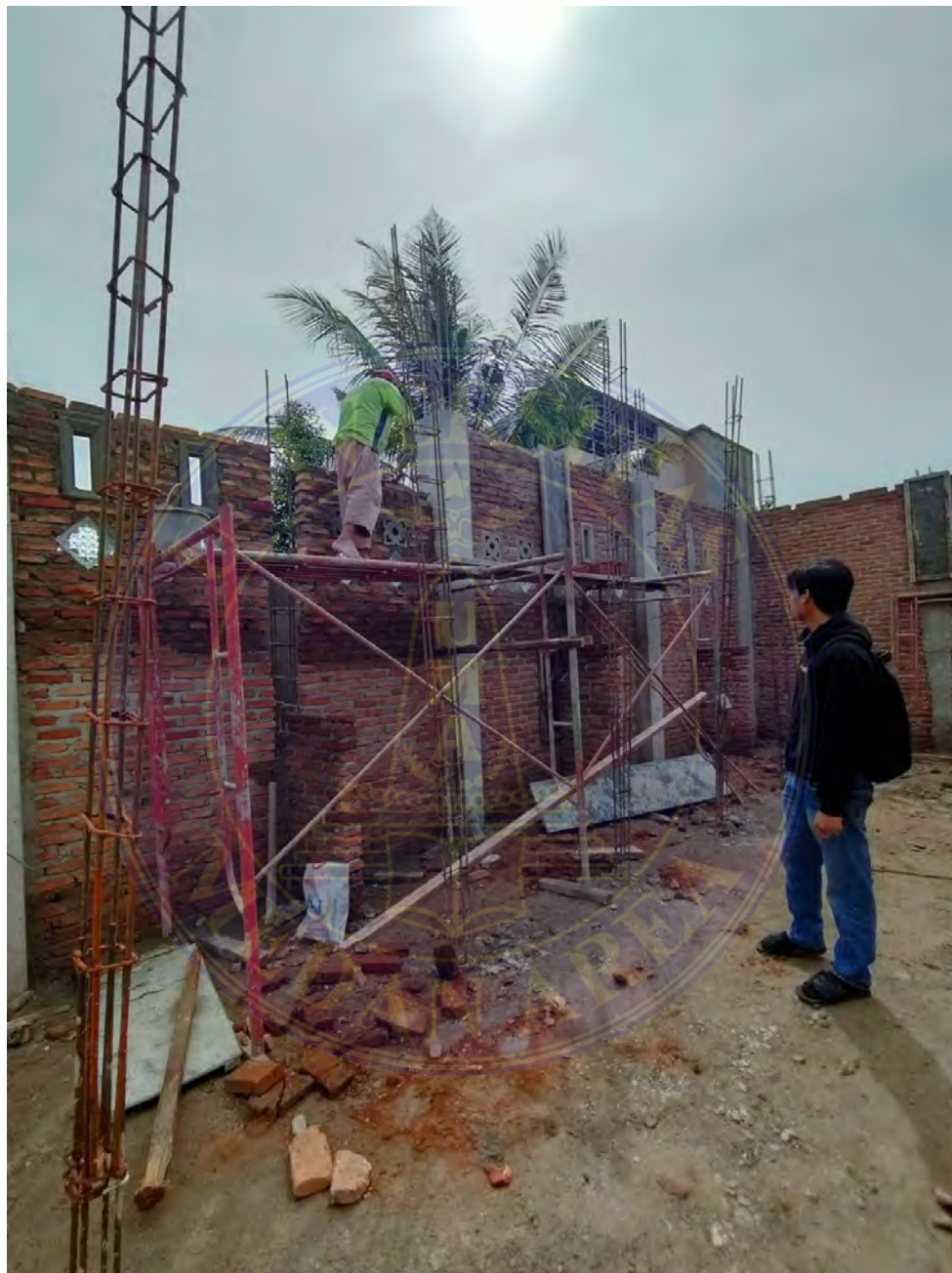
Gambar 3.4. Pengawasan Lanjutan Pemasangan Bata Bagian Luar
