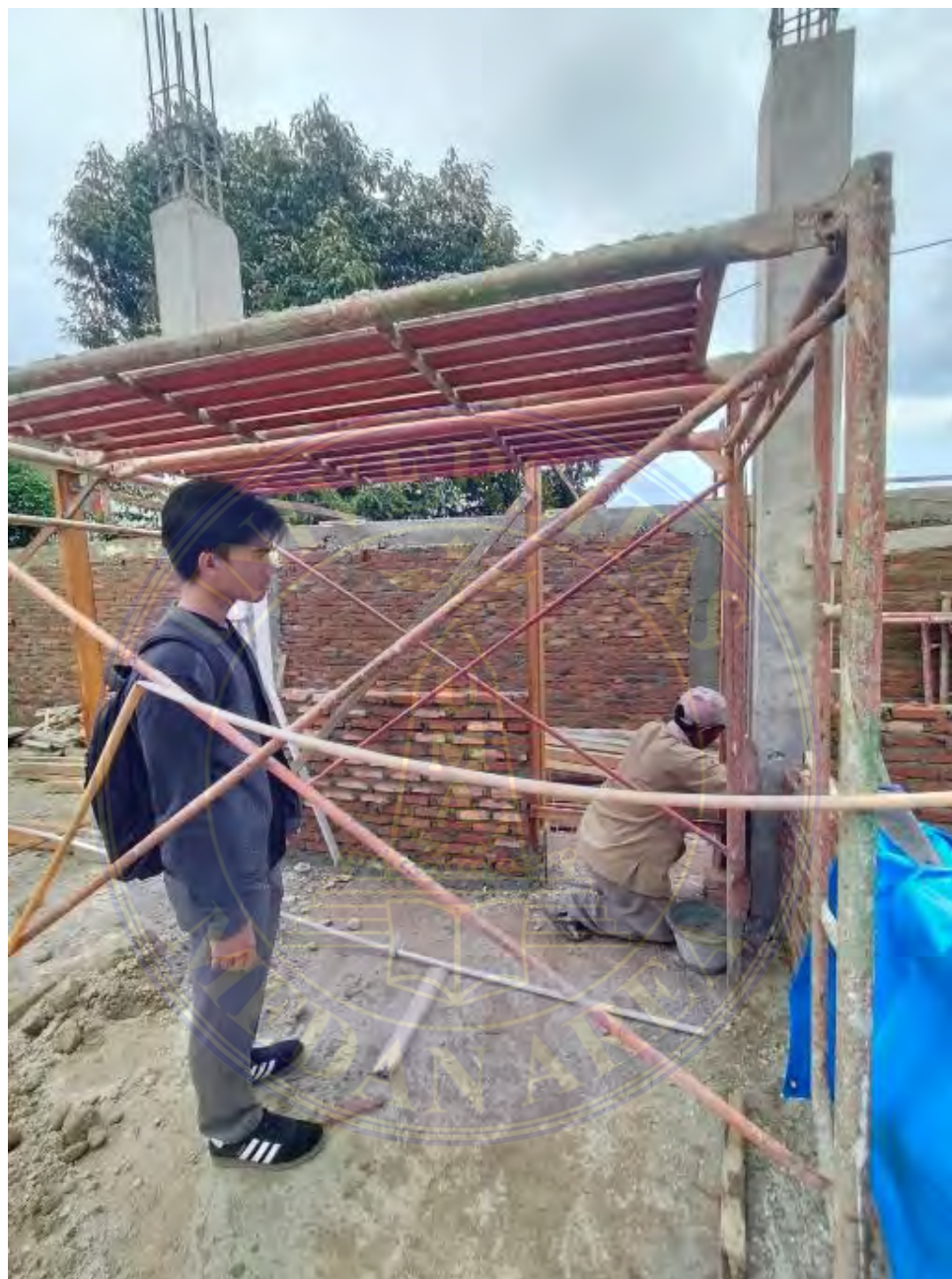
Gambar 3.4. Lanjutan Pengawasan Pemasangan Bata Bagian Pintu Kamar
