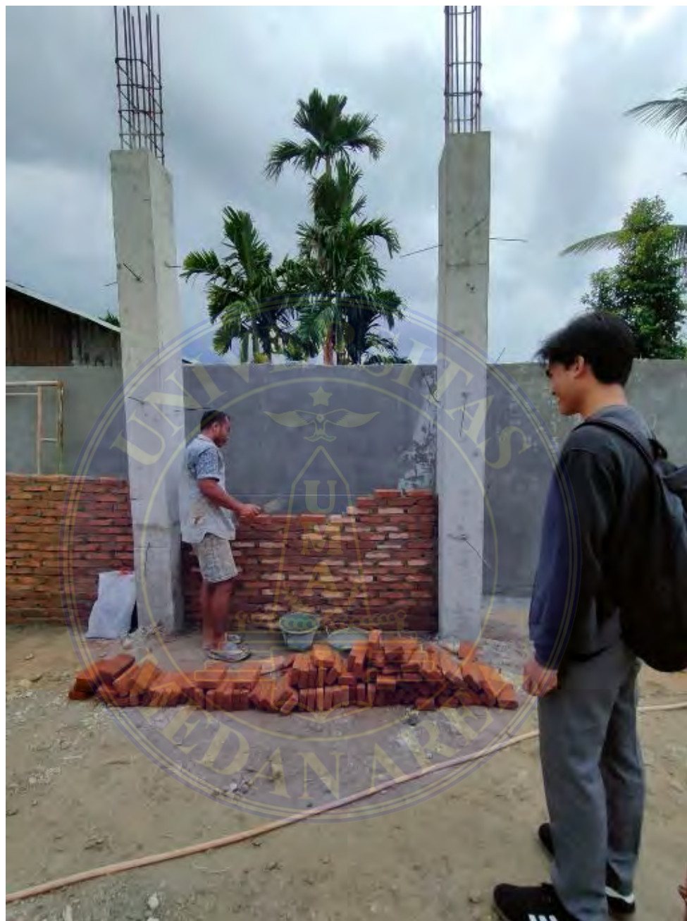
Gambar 3.2. Pengawasan Pemasangan Bata
