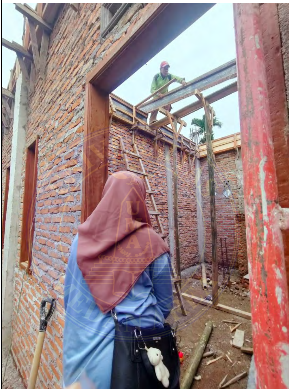
Gambar 3.4. Pengawasan Pemasangan Bekisting untuk Balok uk 25x40
