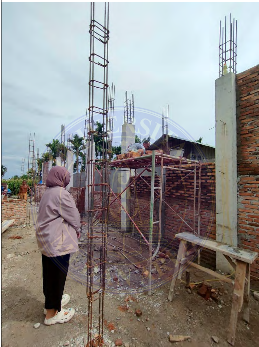
Gambar 3.2. Pengawasan Pekerjaan Dinding dan Struktur Balok
