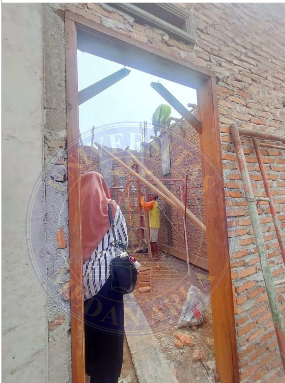
Gambar 3.3. Pengawasan Pemasangan Scaffholder untuk Pembuatan Bekisting Balok
