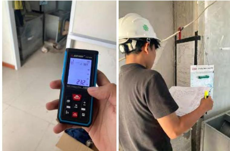
Gambar 3. 5: Pengecekan kembali ukuran ruang menggunakan Laser Distance Meter
