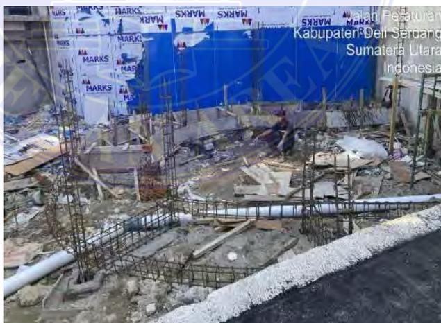
Gambar 3. 11 : Proses Pembesian Struktur Ramp Disabilitas
