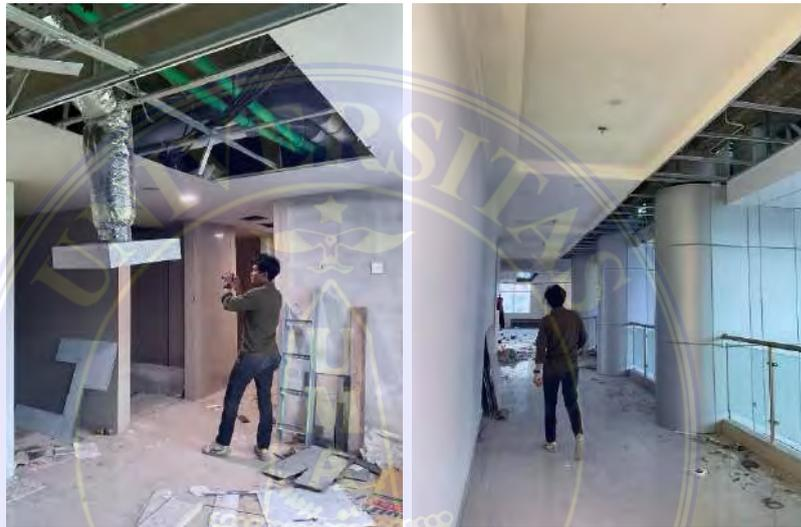
Gambar 3. 8: Pengecekan Pemasangan Diffuser dan silica ceiling di lantai 1-3
