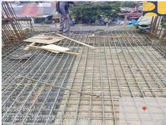
Gambar 4.2 Pemasangan Bekisting
