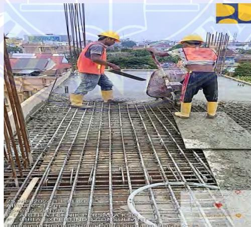
Gambar 4.4 Pengerjaan Pengecoran
