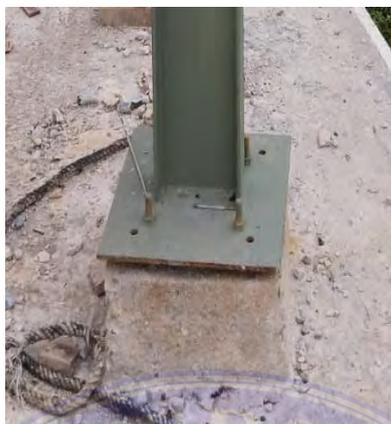
3. Pemasangan Kolom Baja WF 300x150x3,2x4,5 mm yang difabrikasi langsung dengan kolom beton menyesuaikan baut angkur yang tertanam.
